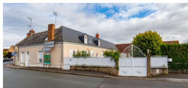
L'ancien bordage de la Croix Blanche. Phot. Pierre-Bernard Fourny IVR52_20197202464NUCA
