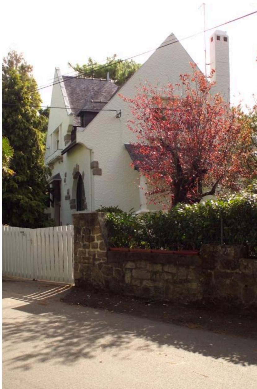
Vue d'ensemble de la villa Ma Bretonne.
