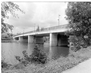
Vue depuis la rive gauche, en aval. Phot. François Lasa IVR52_20025300981X
