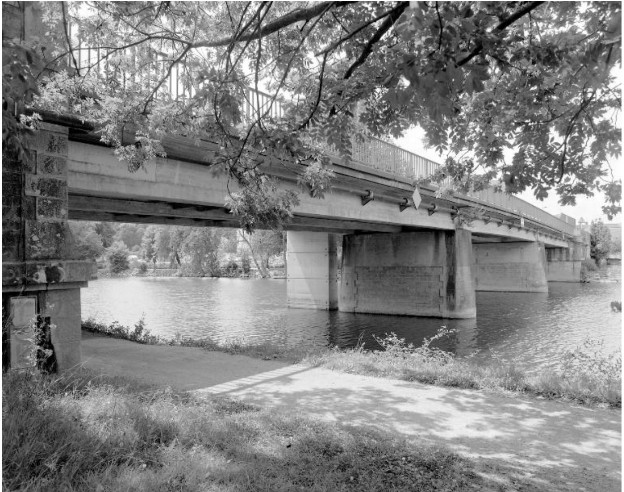
Vue depuis la rive gauche, en amont.
