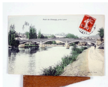
Vue du pont depuis la rive gauche. Repro. François Lasa IVR52_20015300337XA
