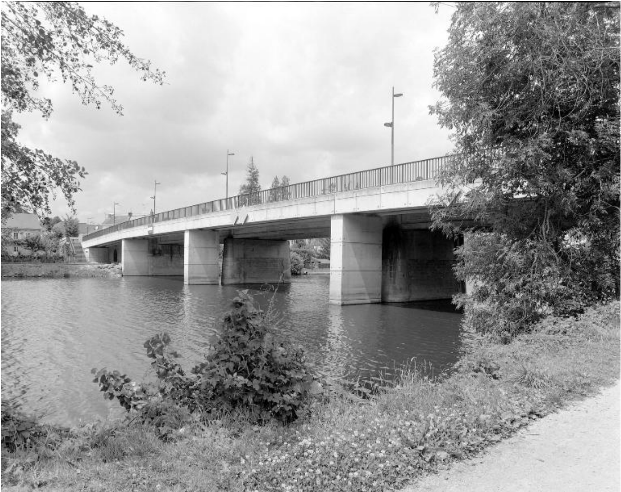
Vue depuis la rive gauche, en aval.
