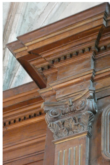
Détail du retable : corniche à denticules, chapiteau composite. Phot. Yannis Suire IVR52_20238502138NUCA
