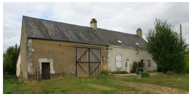
Vue d'ensemble : maison et grange sous un même toit. Phot. Jean-Baptiste Darrasse IVR52_20087202012NUCA
