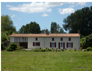
L'ancienne ferme vue depuis l'est. Phot. Yannis Suire IVR52_20228501746NUCA
