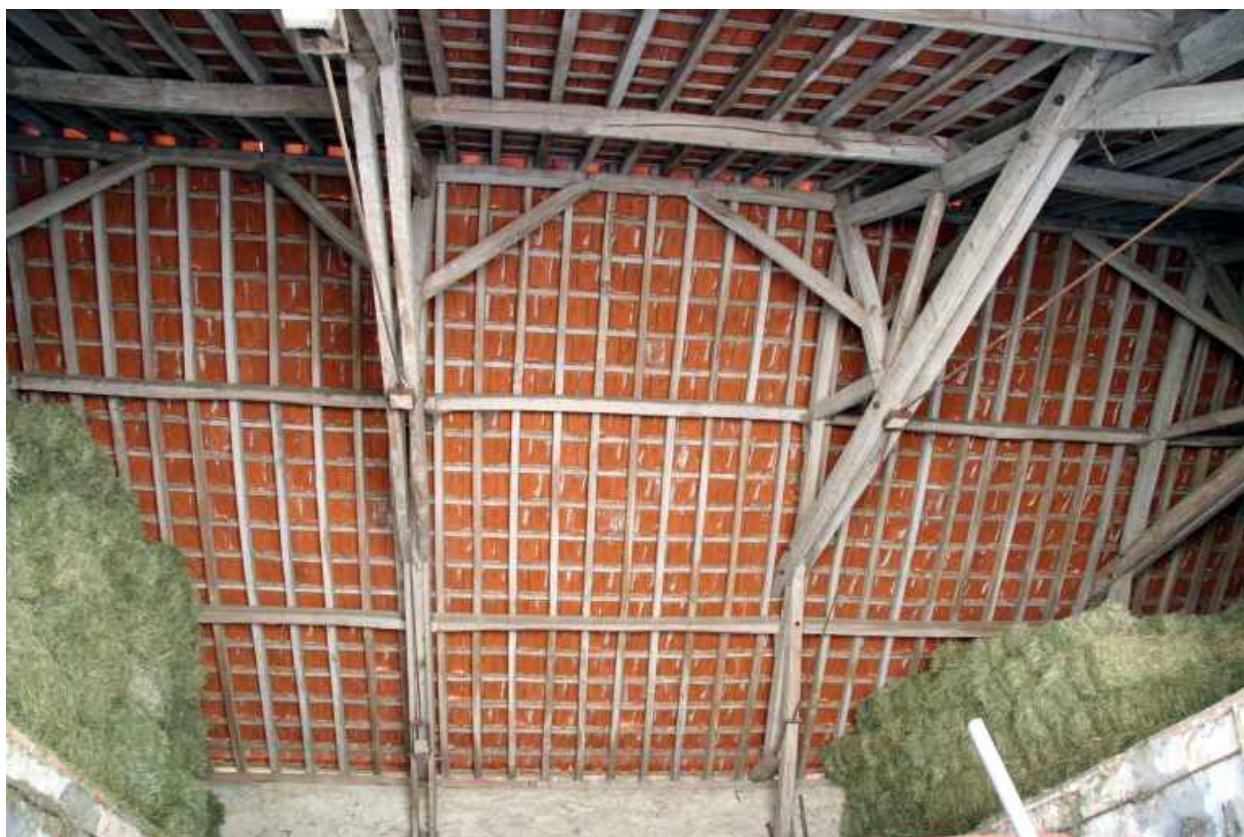
La grange : la charpente
