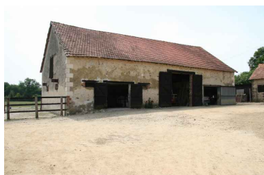
La grange : vue de volume. Phot. Jean-Baptiste Darrasse IVR52_20067206220NUCA
