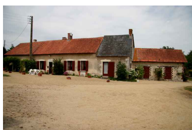
Vue d'ensemble de la maison. Phot. Jean-Baptiste Darrasse IVR52_20067206213NUCA
