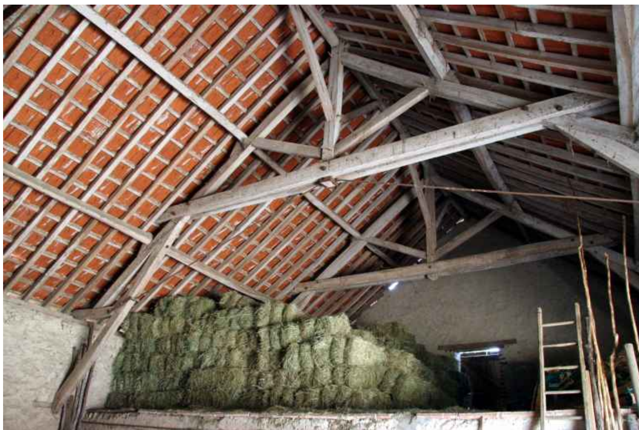
La grange : la charpente.
