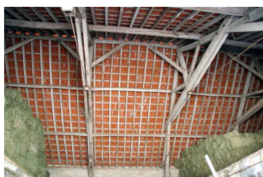
La grange : la charpente Phot. Jean-Baptiste Darrasse IVR52_20067206217NUCA
