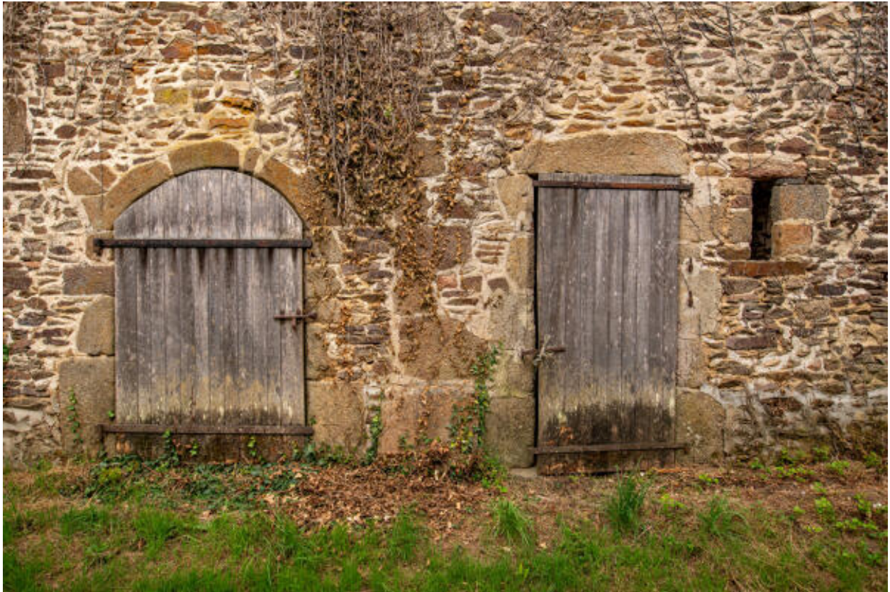
Le corps de dépendances longeant le chemin, détail de portes.
