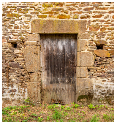
Le corps de dépendances longeant le chemin, détail d'une porte. Phot. Pierre-Bernard Fourny IVR52_20235301086NUCA
