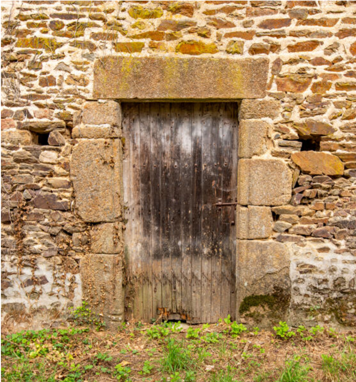
Le corps de dépendances longeant le chemin, détail d'une porte.
