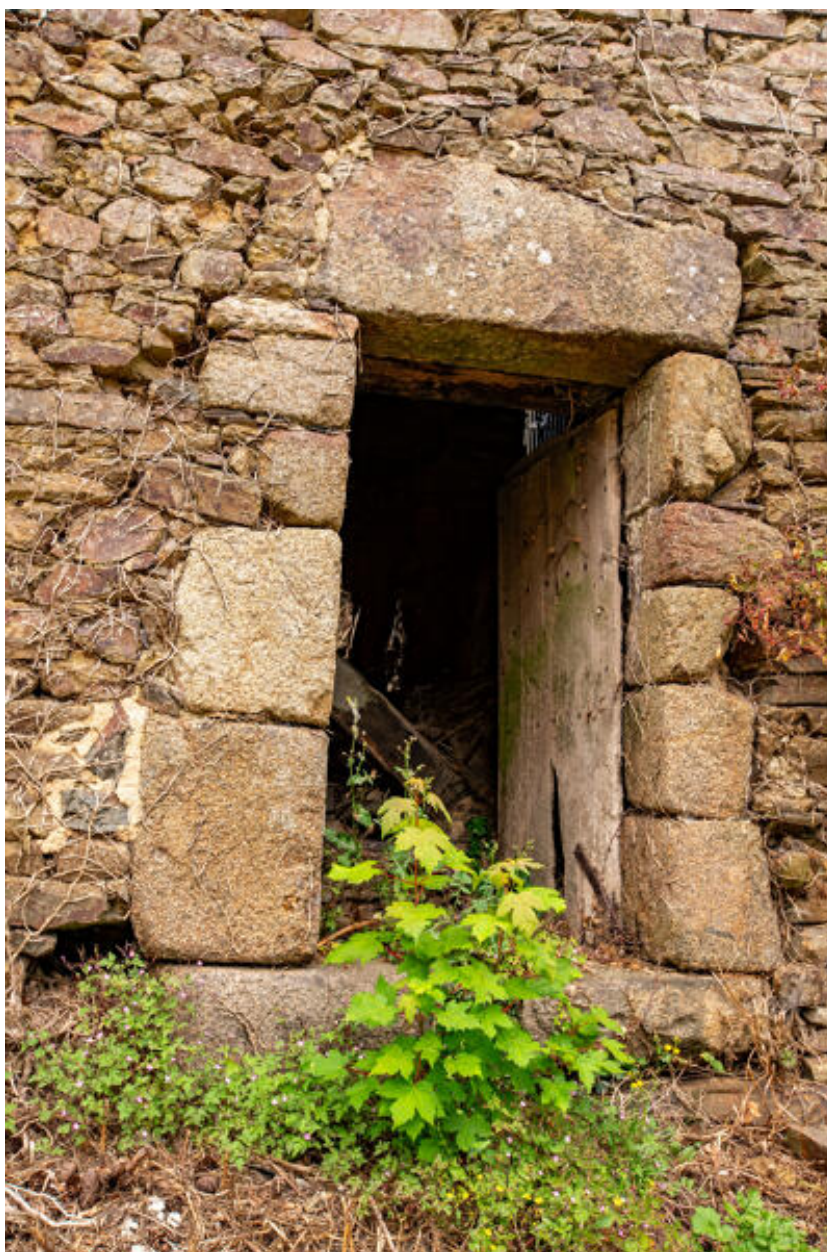
Le pigeonnier, détail de la porte.
