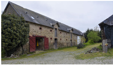
Le corps de dépendance. Phot. Nicolas Foisneau IVR52_20235301798NUCA
