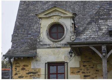
Le logis, détail d'une lucarne. Phot. Nicolas Foisneau IVR52_20235301800NUCA
