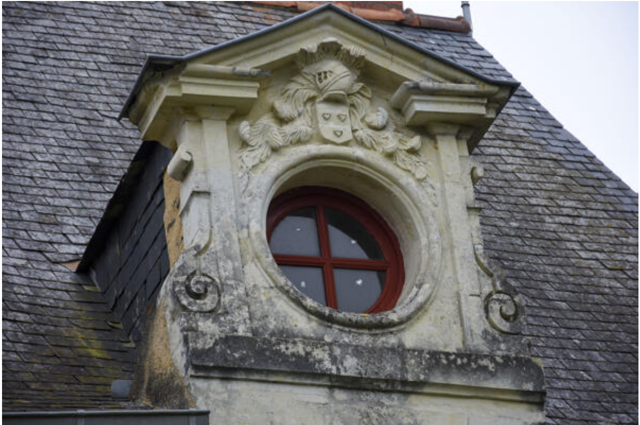
Le logis, détail d'une lucarne.
