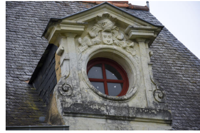
Le logis, détail d'une lucarne. Phot. Nicolas Foisneau IVR52_20235301801NUCA
