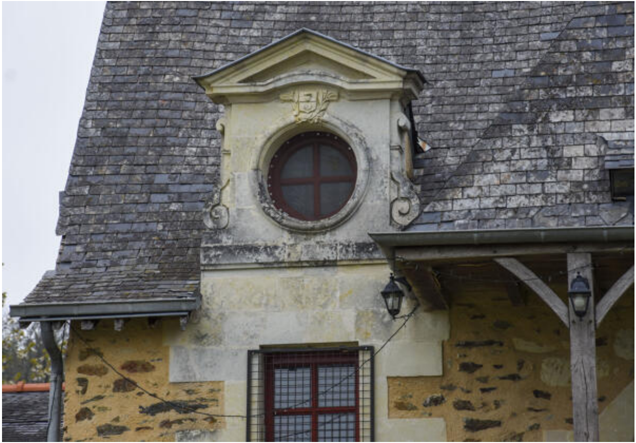
Le logis, détail d'une lucarne.
