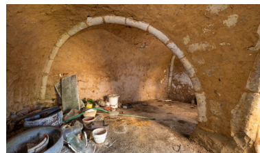
Intérieur du cellier : vue de biais.
