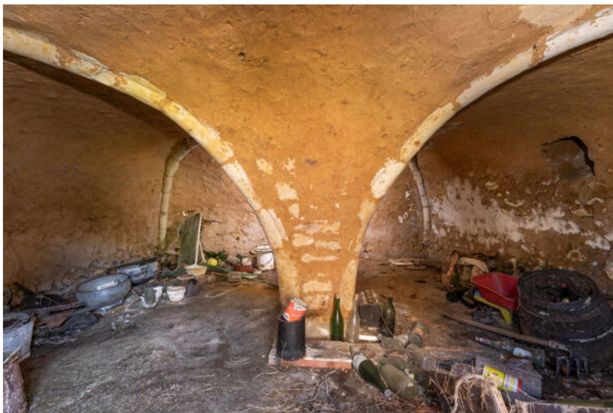
Intérieur du cellier : vue frontale depuis la porte.
