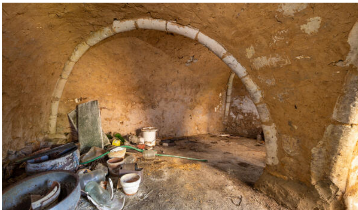
Intérieur du cellier : vue de biais.
