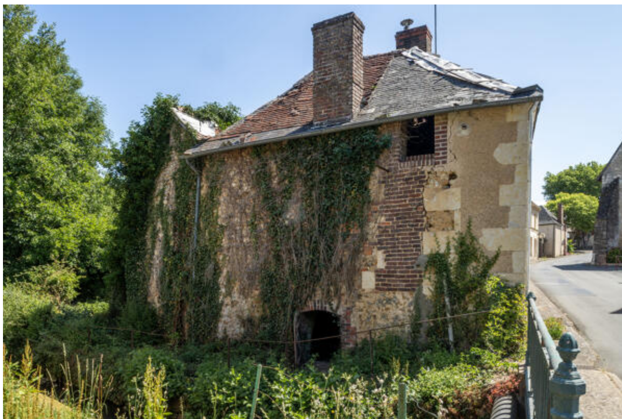
Entrée du cellier en bas du mur ouest de la maison, 5 rue de la Boule d'Or.
