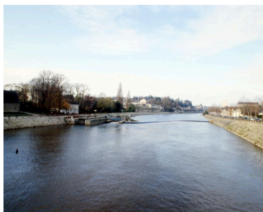
Vue d'ensemble du site depuis le pont d'Avénières, en aval. Phot. François Lasa IVR52_20025301974XA
