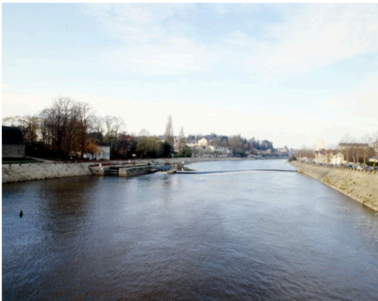
Vue d'ensemble du site depuis le pont d'Avénières, en aval.
