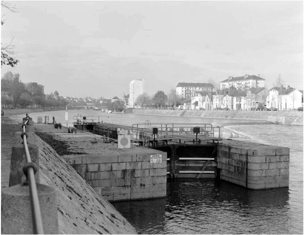
L'écluse vue d'aval.
