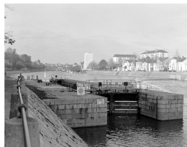
L'écluse vue d'aval. Phot. François Lasa IVR52_20025301979X
