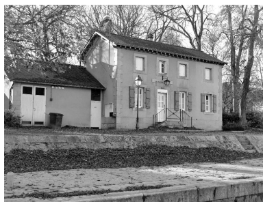
La maison éclusière. Phot. François Lasa IVR52_20025301978X
