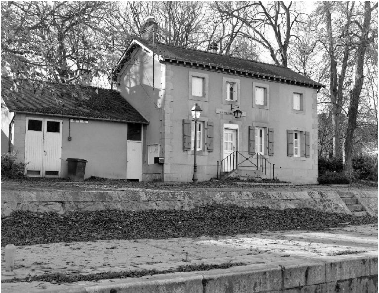
La maison éclusière.
