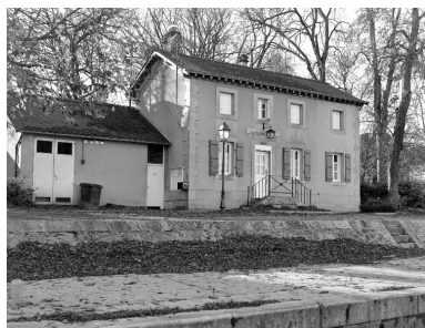
La maison éclusière. Phot. François Lasa IVR52_20025301978X
