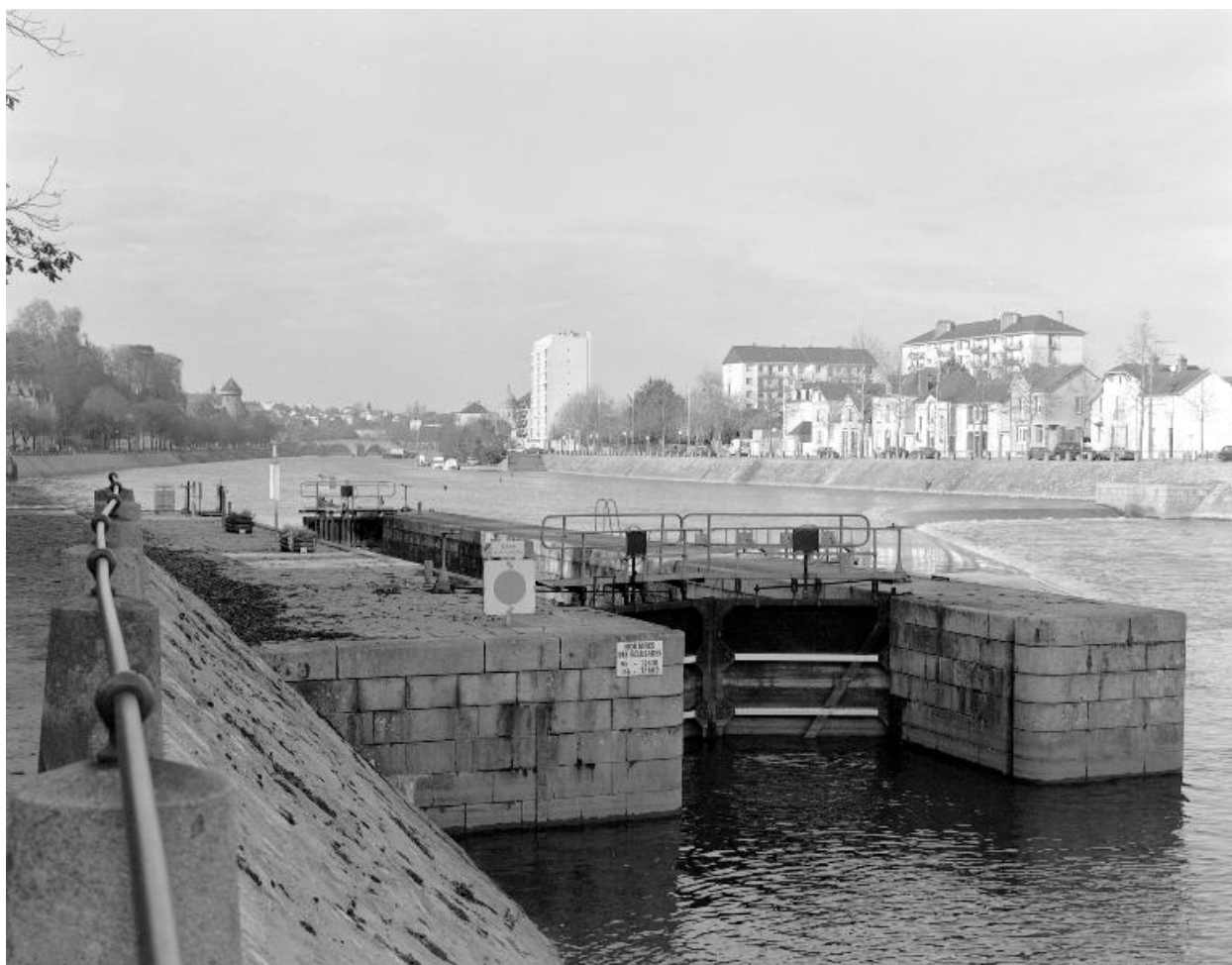
L'écluse vue d'aval.
