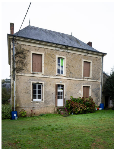
Façade nord. Phot. Thierry Seldubuisson IVR52_20247200359NUCA
