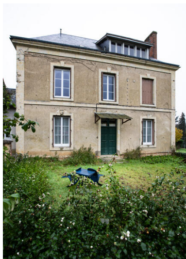
Façade sud. Phot. Thierry Seldubuisson IVR52_20247200358NUCA
