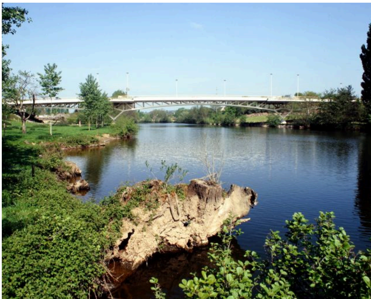
Vue d'ensemble, depuis l'aval.
