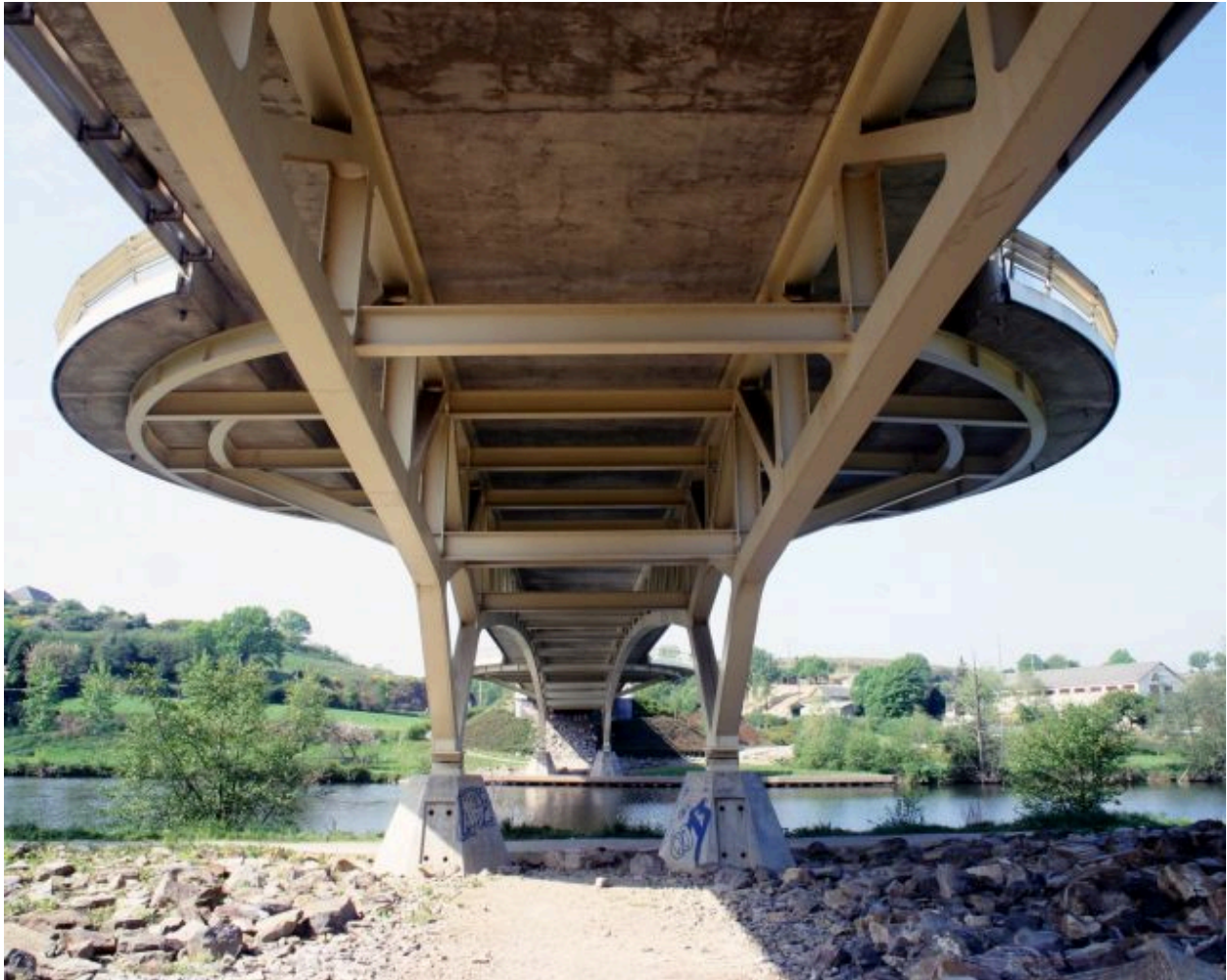
Vue de la structure métallique, sous le tablier, depuis la rive droite.
