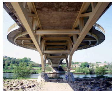
Vue de la structure métallique, sous le tablier, depuis la rive droite. Phot. François Lasa IVR52_20025300604XA
