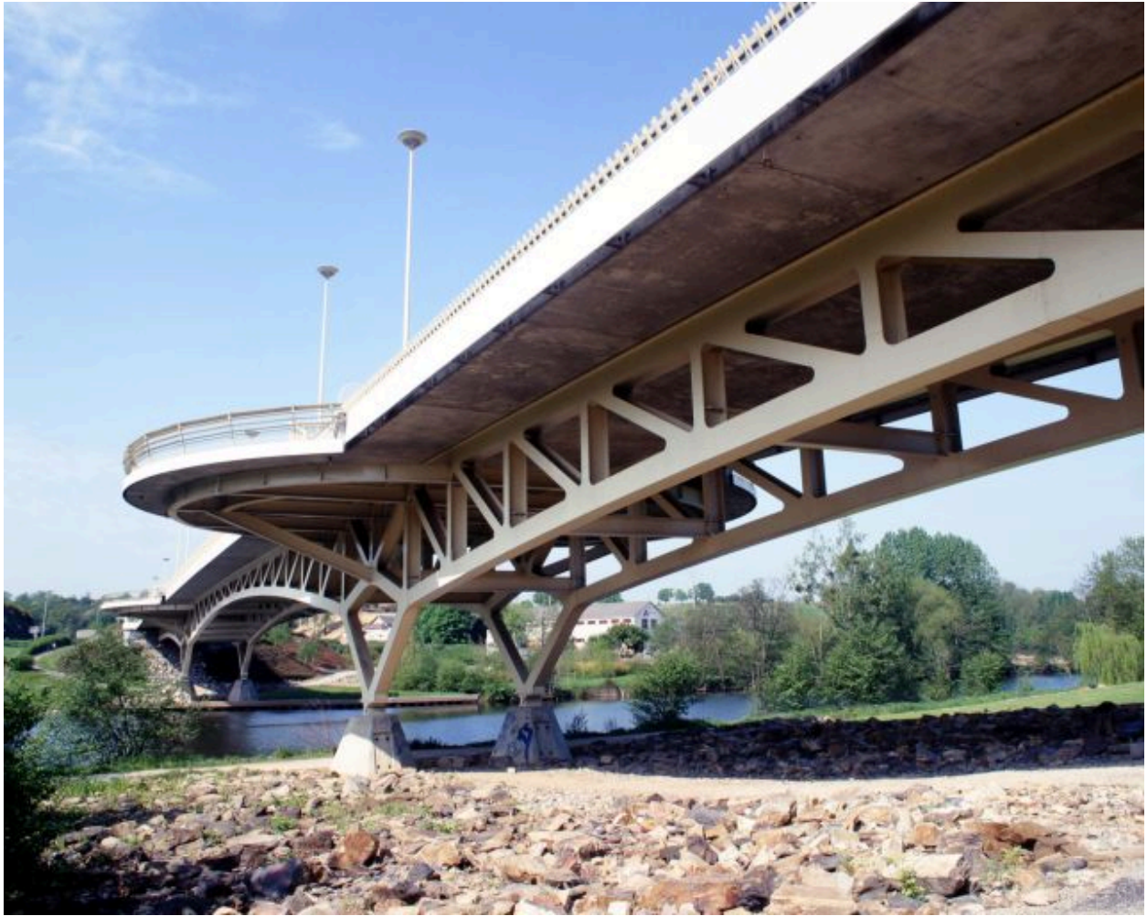
Vue d'ensemble, depuis la rive droite.
