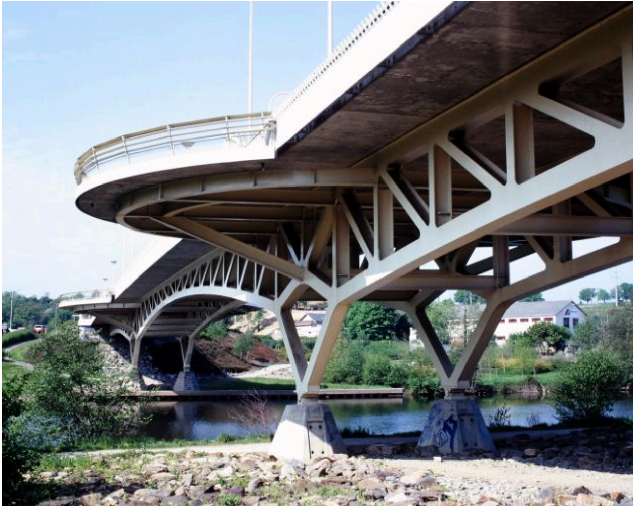
Vue d'ensemble, depuis la rive droite.
