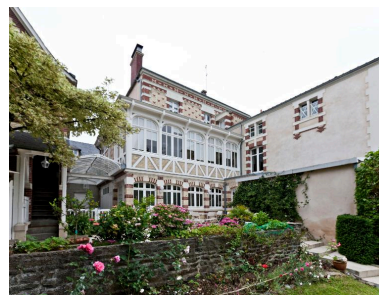
Logis, arrière-corps et aile en retour d'équerre : vue d'ensemble. Phot. Yves Guillotin IVR52_20135300633NUCA
