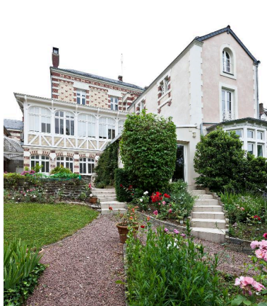
Logis, arrière-corps et aile en retour d'équerre : vue d'ensemble. Phot. Yves Guillotin IVR52_20135300631NUCA
