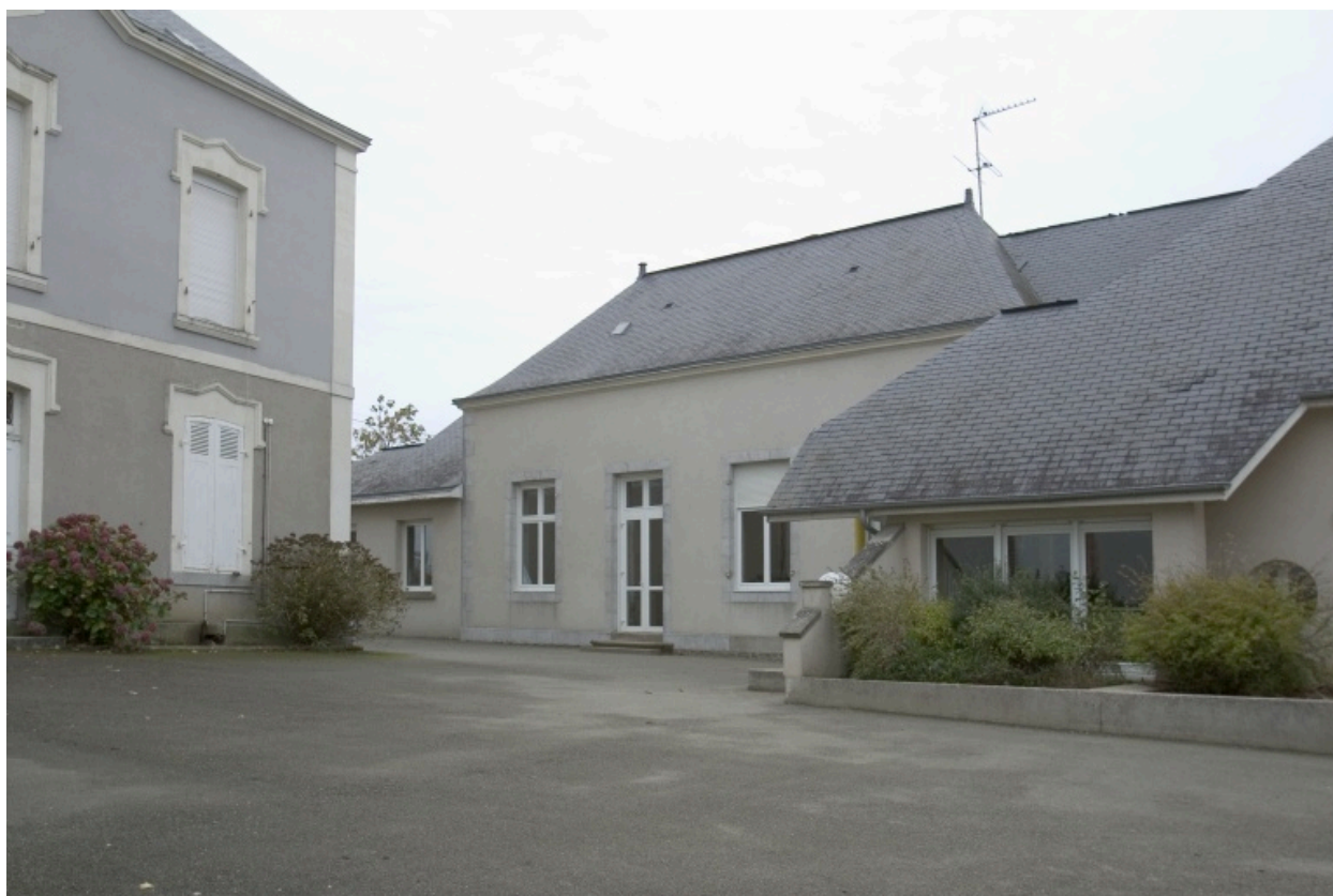
Les classes vues depuis la cour au nord-est.
