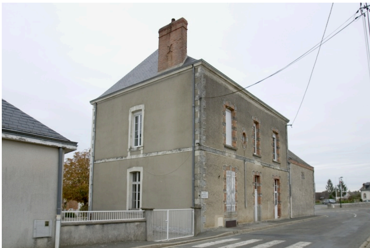
La façade sur la rue et la façade latérale de l'ancienne maison des soeurs vues depuis le sud-ouest.
