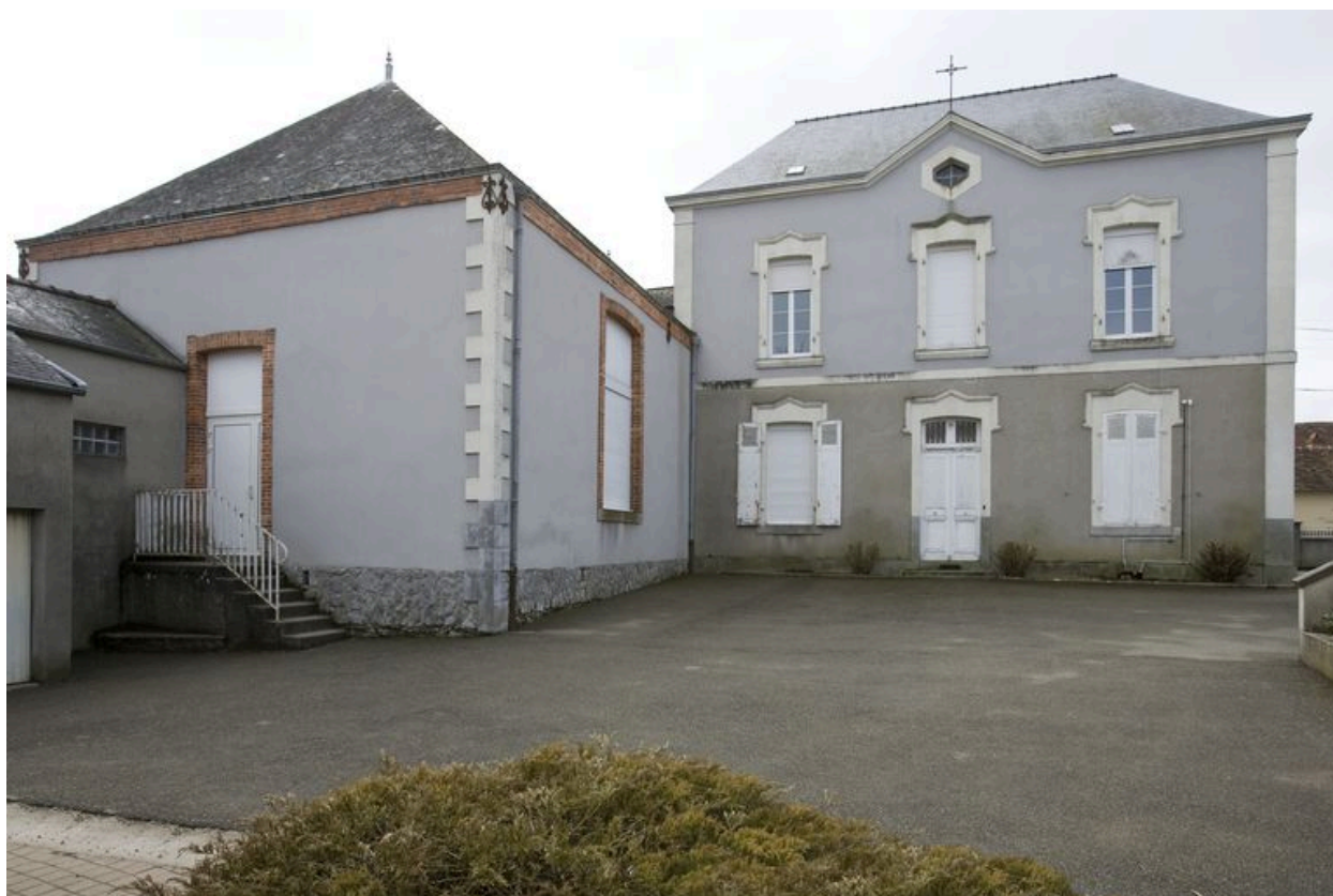
La façade sur la cour de l'ancienne maison des soeurs vue depuis le nord.
