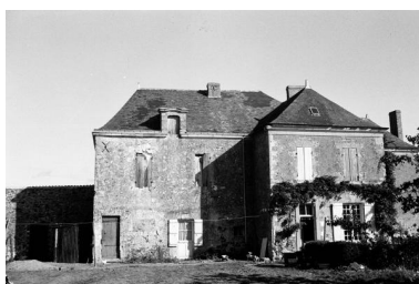
Façade antérieure et aile en retour d'équerre, 1972. Phot. Marie-Anne Eon IVR52_19724900383Z
