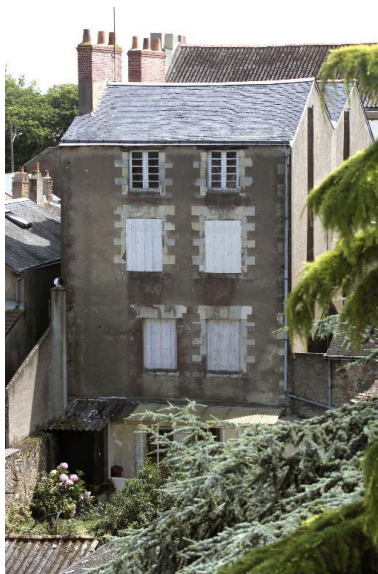
La façade postérieure vue de la maison n° 19 rue du Général-De-Gaulle. Phot. Denis Pillet IVR52_20034400498NUCA
