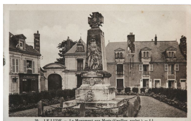
Vue d'ensemble. Repro. Jean-Baptiste Darrasse IVR52_20067207305NUCA
