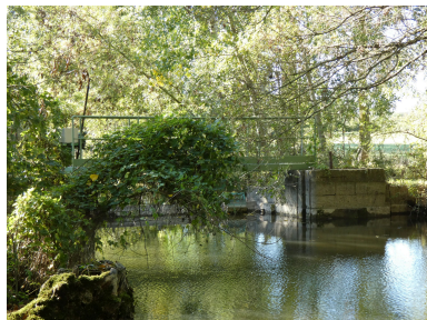
Le barrage vu depuis l'est, en amont. Phot. Yannis Suire IVR52_20228500755NUCA
