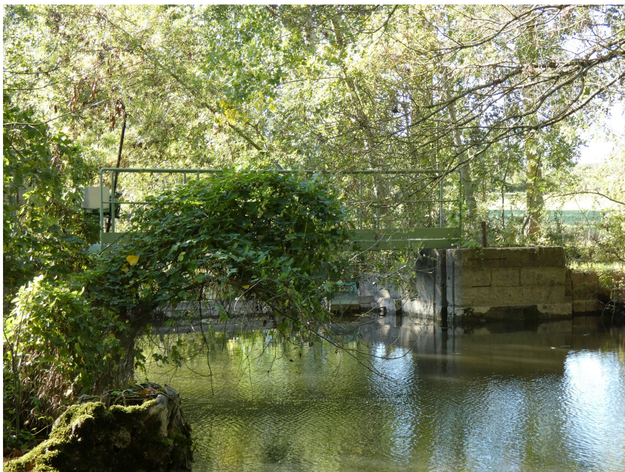
Le barrage vu depuis l'est, en amont.
