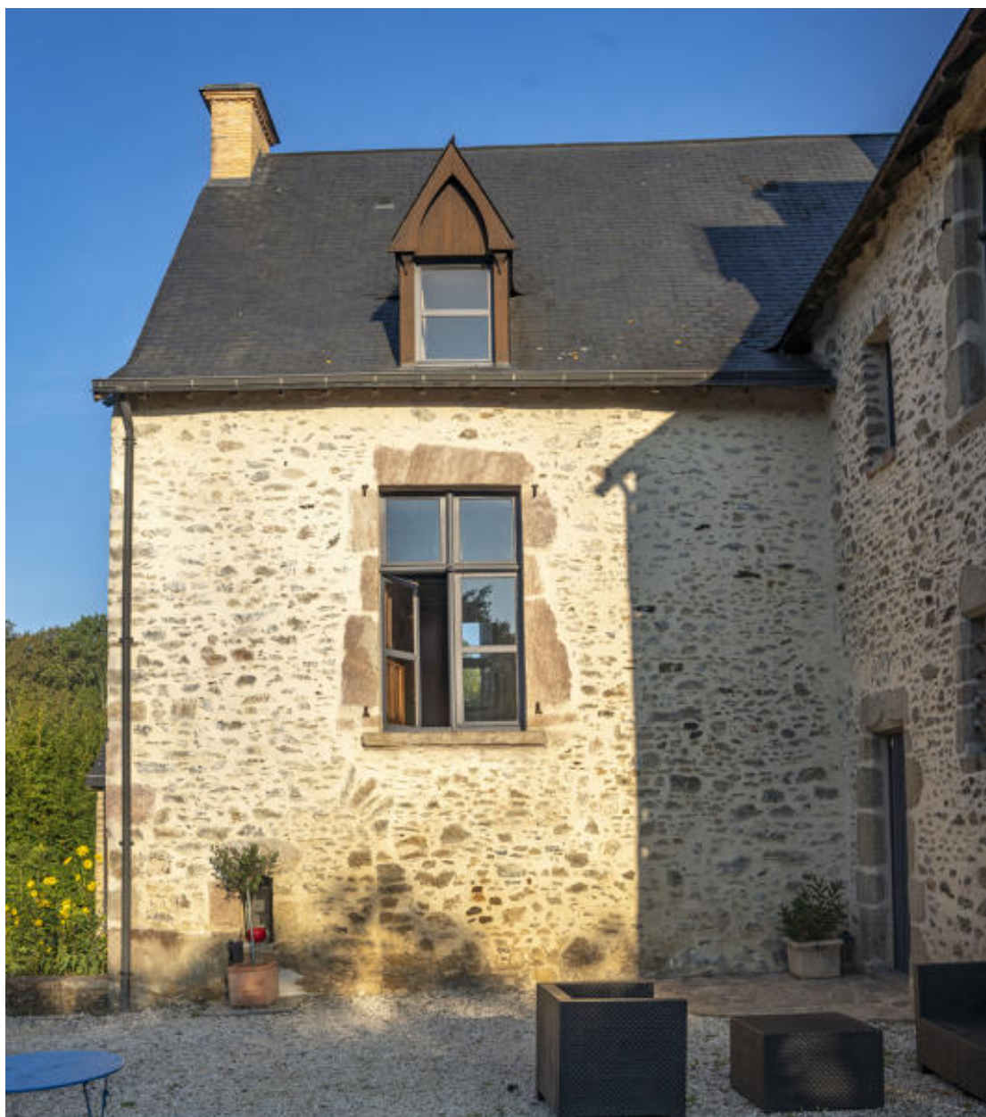
La façade antérieure du corps principal.
