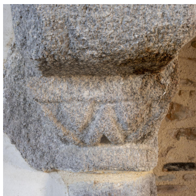
La cheminée de l'étage, détail. Phot. Pierre-Bernard Fourny IVR52_20215301214NUCA
