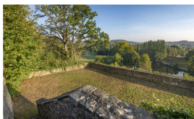
La terrasse. Phot. Pierre-Bernard Fourny IVR52_20215301204NUCA
