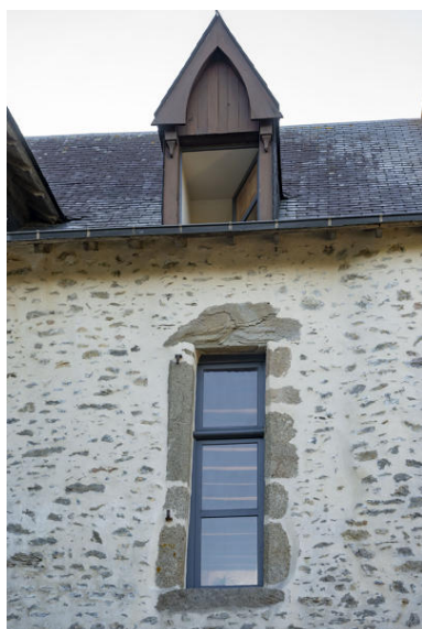
Une baie à accolade. Phot. Pierre-Bernard Fourny IVR52_20215301201NUCA
