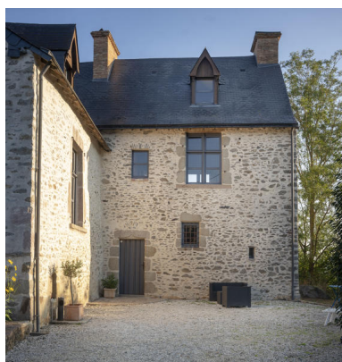
La façade antérieure de l'aile en retour. Phot. Pierre-Bernard Fourny IVR52_20215301195NUCA
