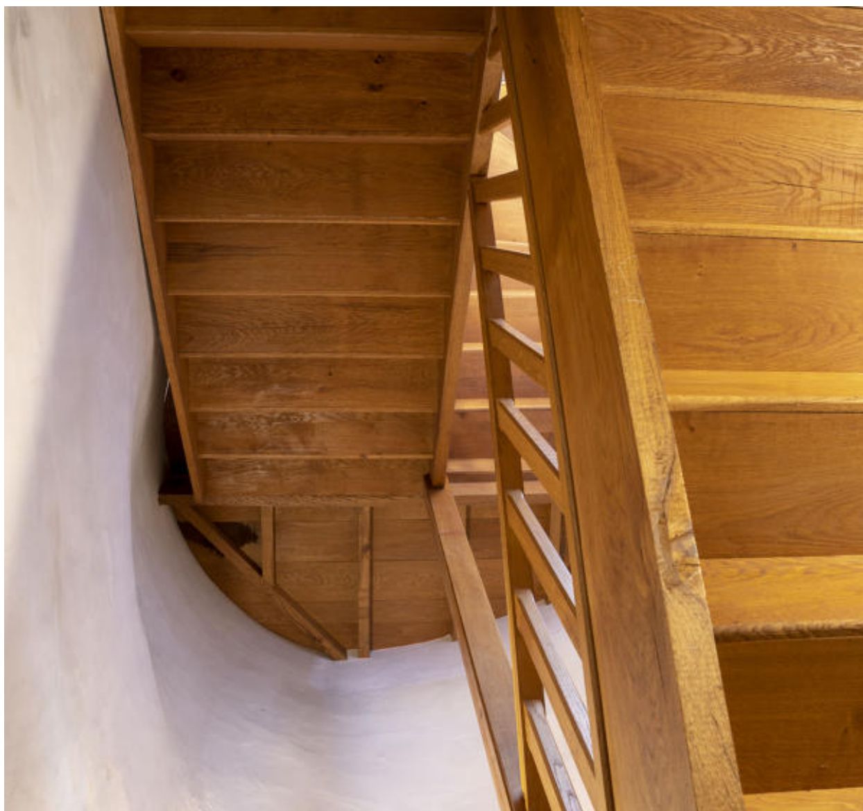
L'emplacement d'un ancien escalier à vis.
