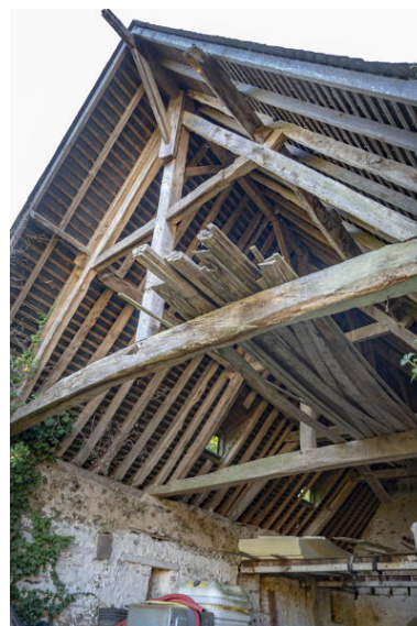
La charpente de la grange. Phot. Pierre-Bernard Fourny IVR52_20215301219NUCA
