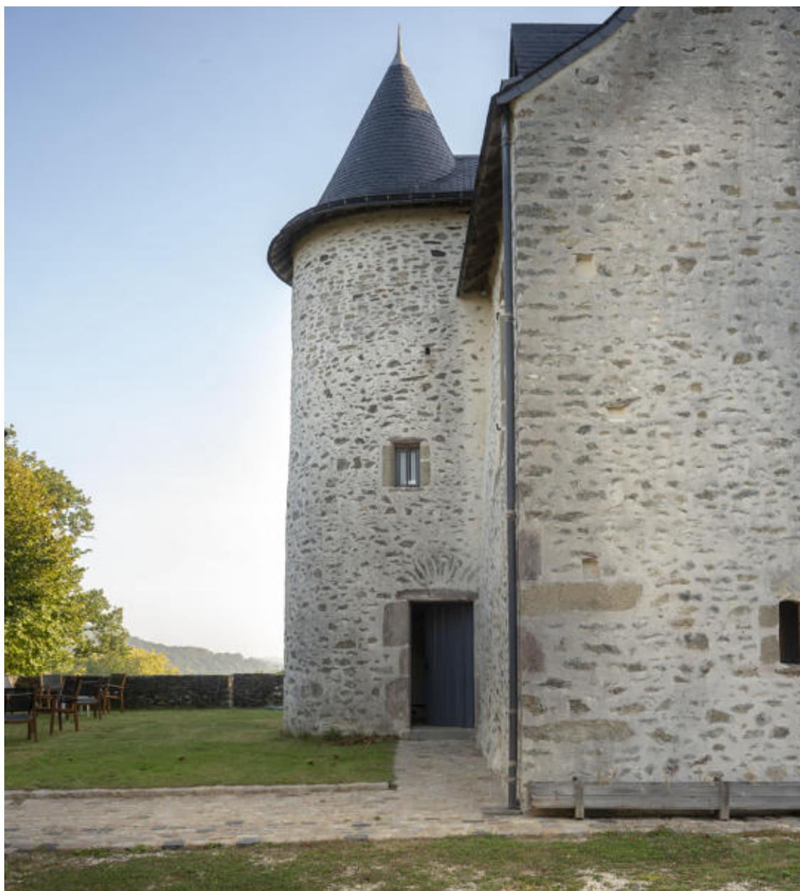
La tour d'escalier.
