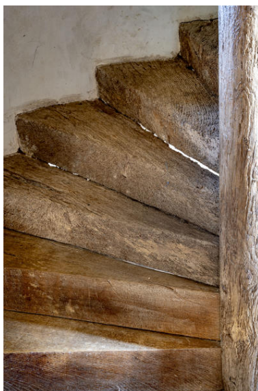
L'escalier à vis, détail. Phot. Pierre-Bernard Fourny IVR52_20215301208NUCA
