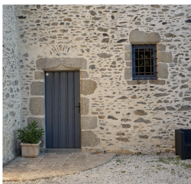
La porte et la fenêtre de l'aile en retour. Phot. Pierre-Bernard Fourny IVR52_20215301196NUCA
