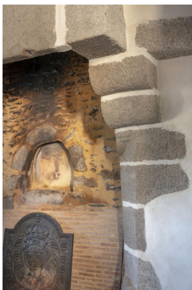
La cheminée du rez-de-chaussée, détail. Phot. Pierre-Bernard Fourny IVR52_20215301211NUCA
