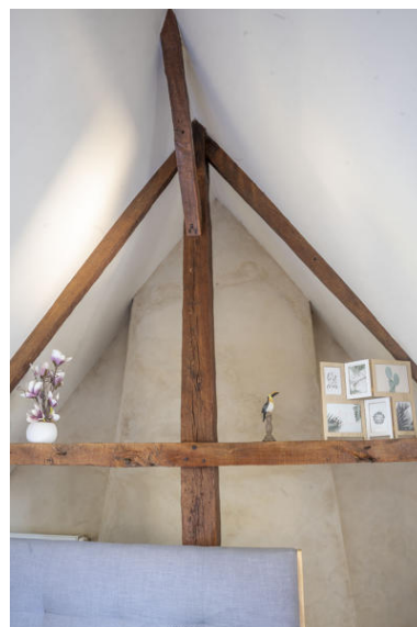
Une ferme de la charpente. Phot. Pierre-Bernard Fourny IVR52_20215301216NUCA
