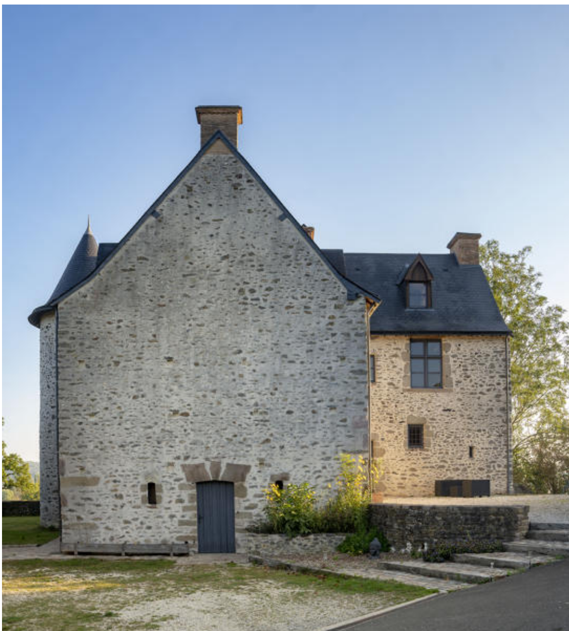
Le pignon du corps principal.
