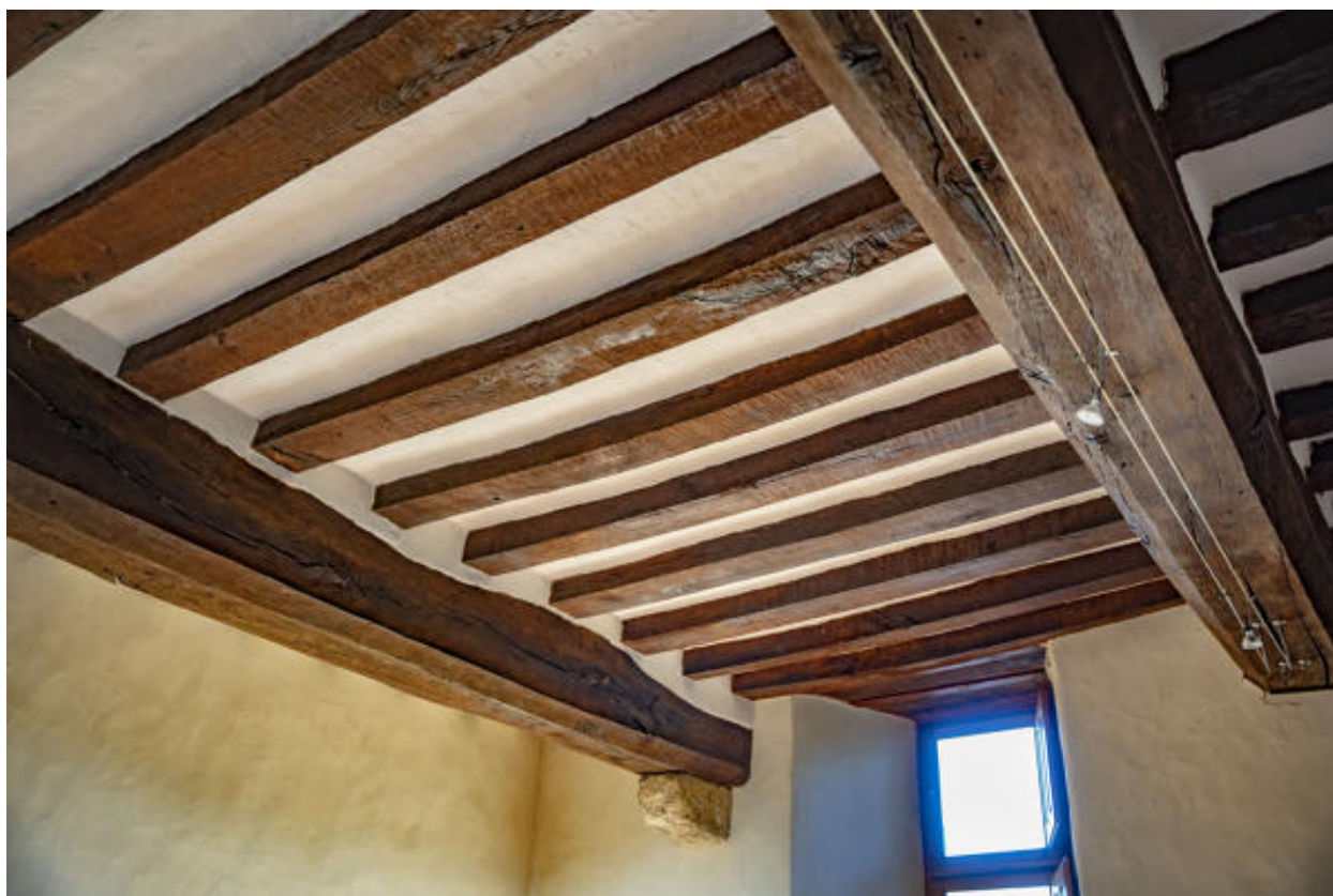
Le plafond à l'étage du corps principal.
