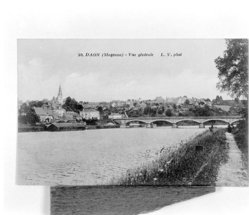
Vue d'ensemble du village et du pont de Daon depuis le chemin de halage, rive droite, en amont. Autr. Valentin Laroute, Repro. François Lasa IVR52_20015300352X
