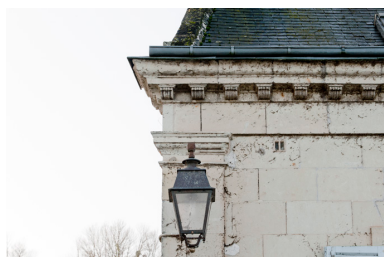
Vocabulaire architectural néoclassique : détail de l'entablement et d'un pilastre de la maison du 4, quai Alexandre Dumas. Phot. Bruno Rousseau IVR52_20124900035NUCA
