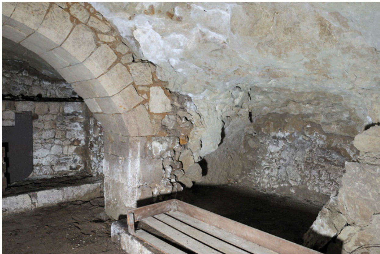
Deuxième travée : élargissement par excavation dans l'angle sud-ouest.
