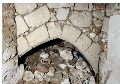
Première travée : arc brisé chanfreiné couvrant un ancien accès bas qui donnait, à l'ouest, sur une galerie ou un caveau (effondrement). Phot. Bruno Rousseau, Phot. Youenn Communeau IVR52_20114902232NUCA
