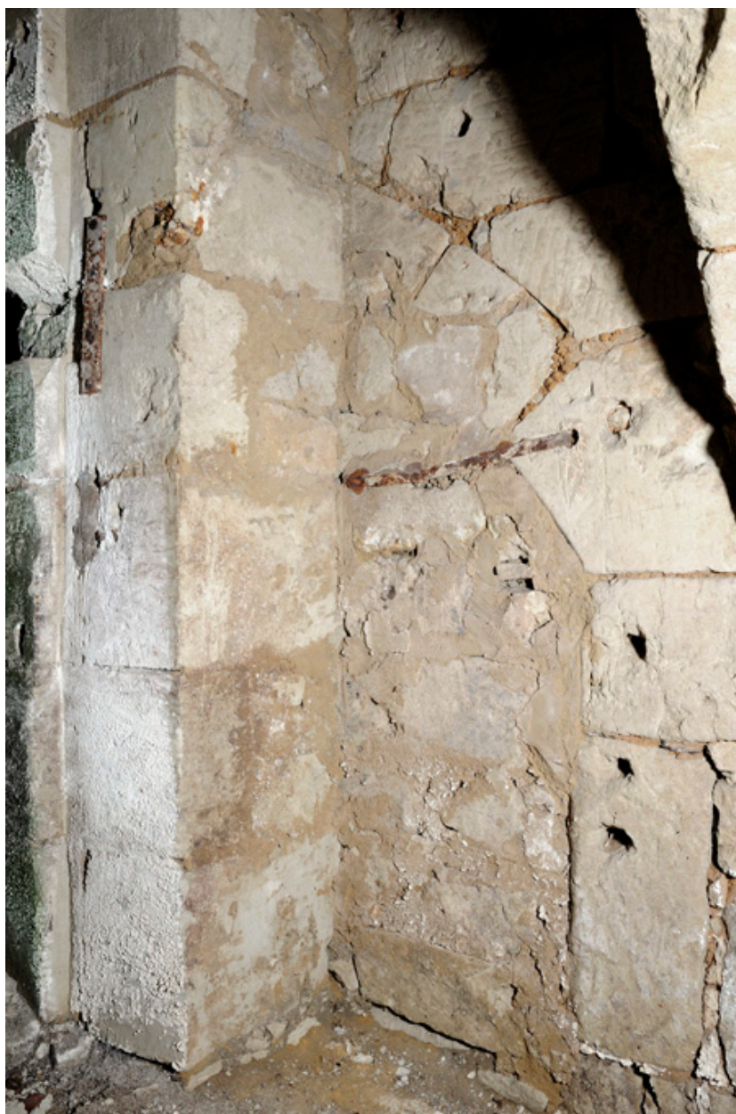
Première travée : alette et mur rétrécissant l'ancienne arcade menant au caveau est..
