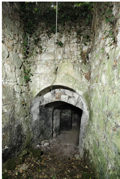
Vue générale : entrée de l'abri. Phot. Bruno Rousseau, Phot. Youenn Communeau IVR52_20114902235NUCA
