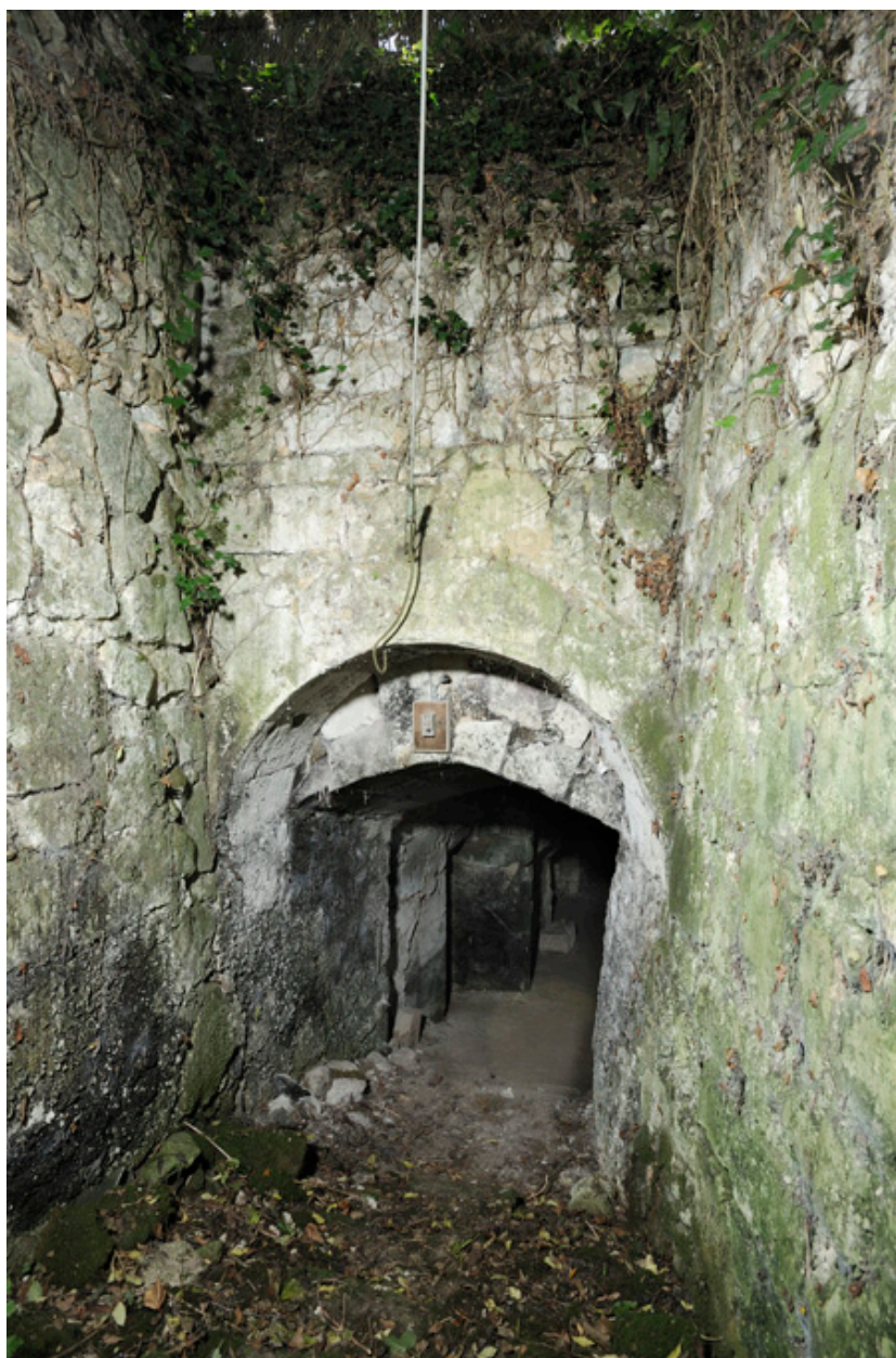
Vue générale : entrée de l'abri.
