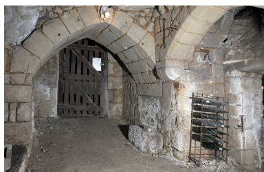
Deuxième travée : vue d'ensemble, avec l'arcade de séparation des deux
