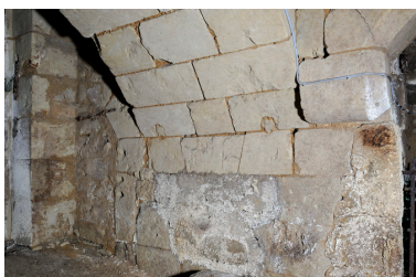
Deuxième travée : détail de la retombée de l'arcade avec niche basse couverte d'une plate-bande (obturée).
