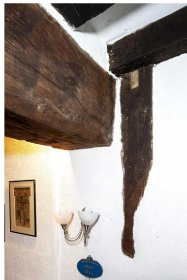
Vestige de poteau de la structure primitive, noyé dans la maçonnerie du mur-gouttereau nord.
