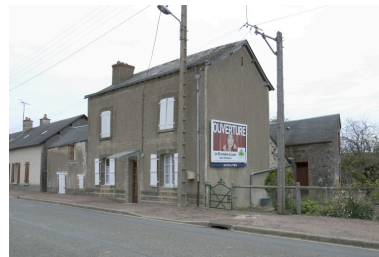
Vue depuis la route. Phot. François Lasa IVR52_20045303316NUCA
