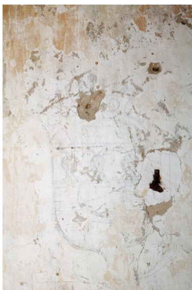
Corps de logis central, premier étage, pièce dite du "palier" : écu aux armes de Marie Perrot.
