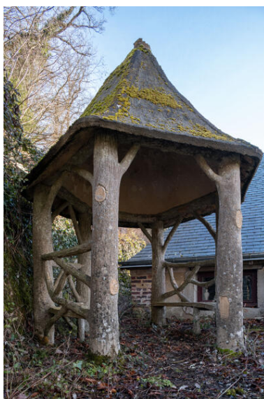
Fabrique de jardin en béton rustiqué. Phot. Jeanne Minier IVR52_20267200213NUCA
