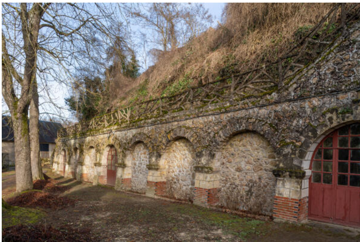
Aménagements troglodytiques et promenade en surplomb.
