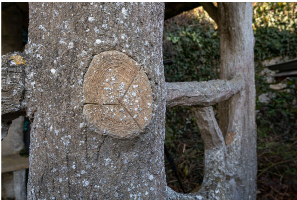
Fabrique de jardin en béton rustiqué : détail.
