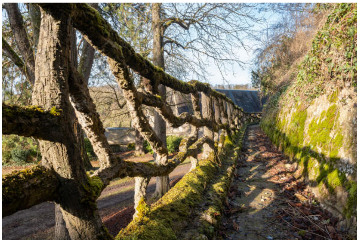
Garde-corps en béton rustiqué.
