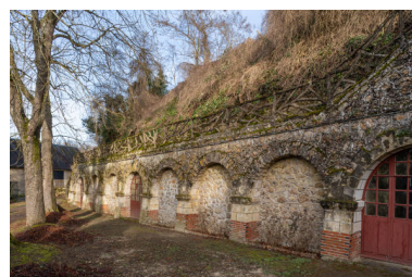
Aménagements troglodytiques et promenade en surplomb.
