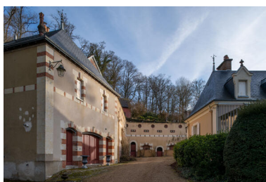
Remise et aménagements troglodytiques.
