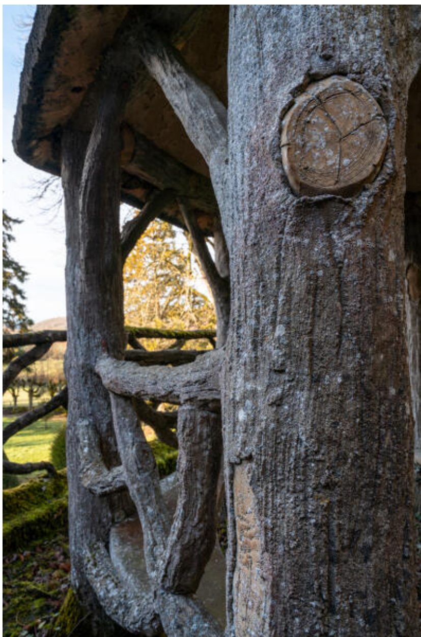
Fabrique de jardin en béton rustiqué : détail.
