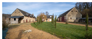
La ferme : vue d'ensemble. Phot. Jeanne Minier IVR52_20267200221NUCA
