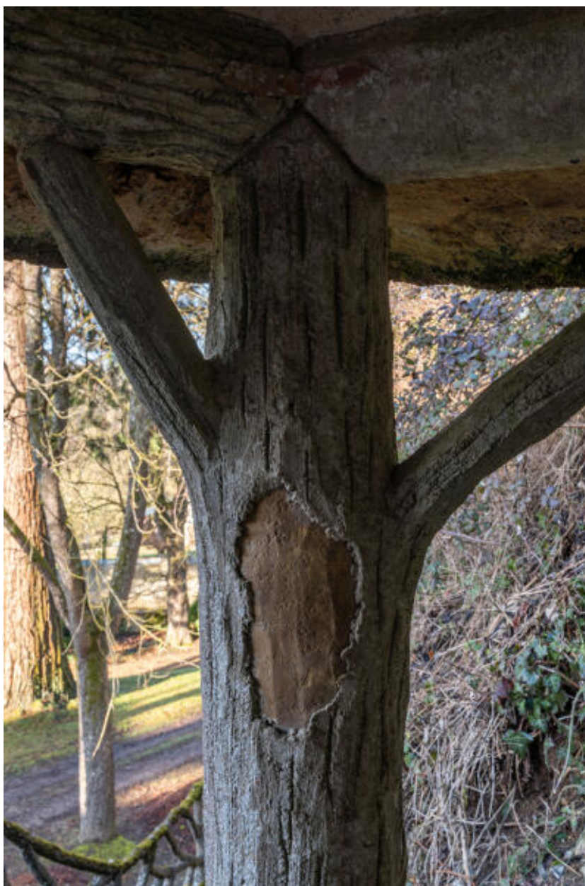
Fabrique de jardin en béton rustiqué : détail.
