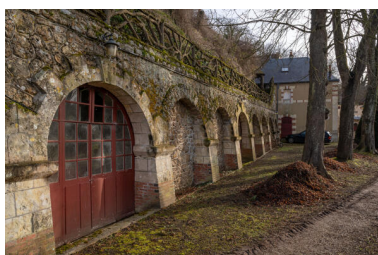
Aménagements troglodytiques et promenade en surplomb.
