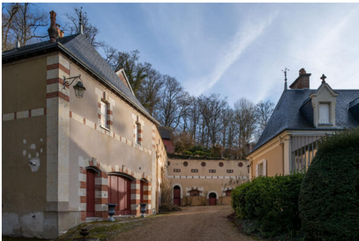
Remise et aménagements troglodytiques.
