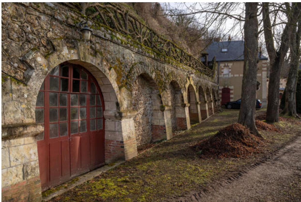
Aménagements troglodytiques et promenade en surplomb.
