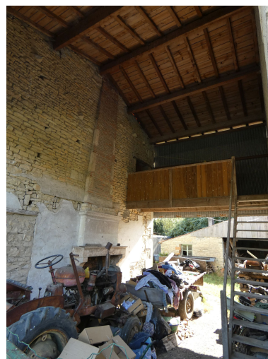
Le passage couvert. Phot. Yannis Suire IVR52_20228500314NUCA
