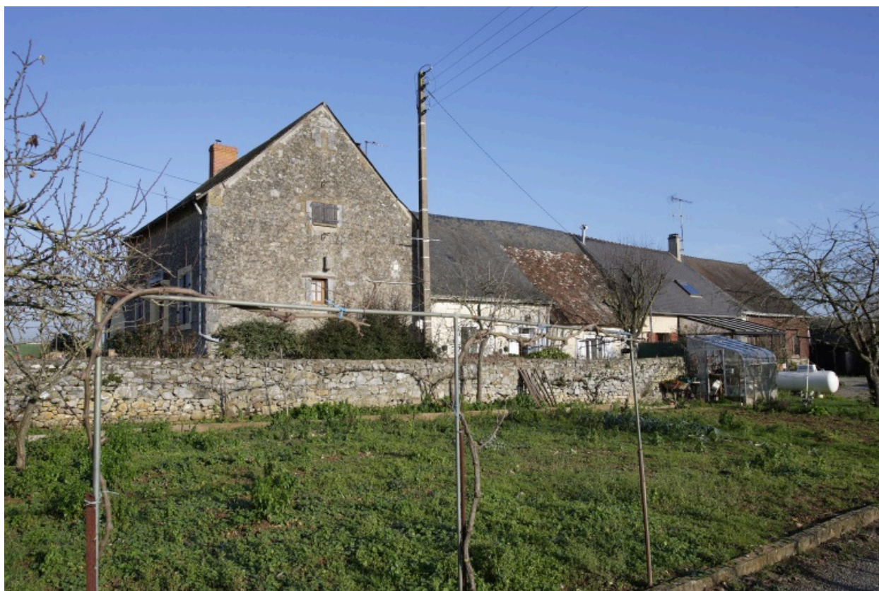
Vue d'ensemble depuis le sud-ouest. De gauche à droite : le troisième logis, le premier logis avec son extension du XIXe siècle et le deuxième logis que prolonge l'ancien hangar.
