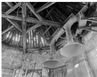
Vue de la charpente et du système d'évacuation des fumées.
