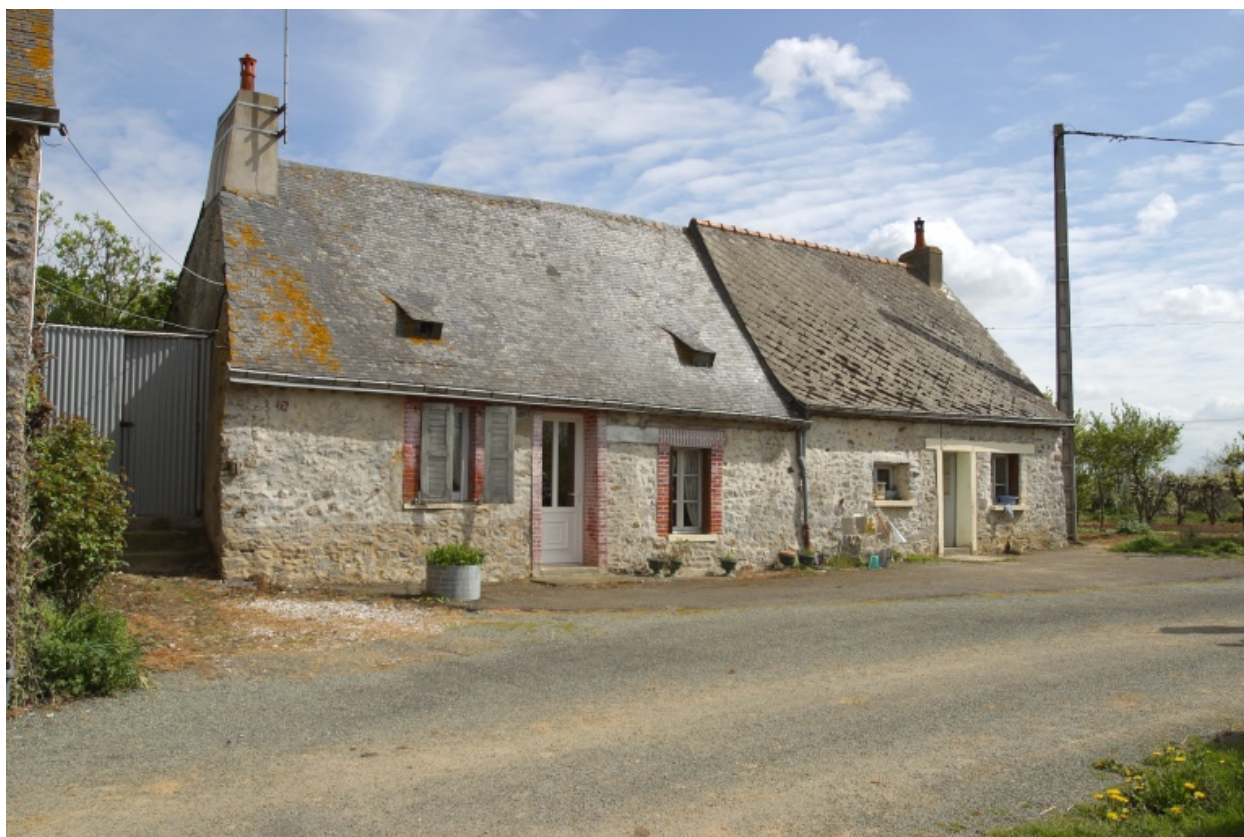
Le logis : façade principale.
