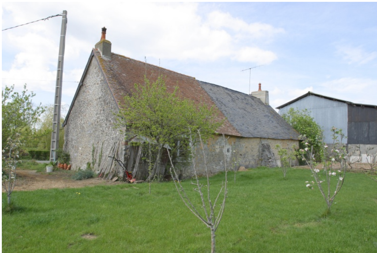
Le logis : façade arrière et pignon sud.
