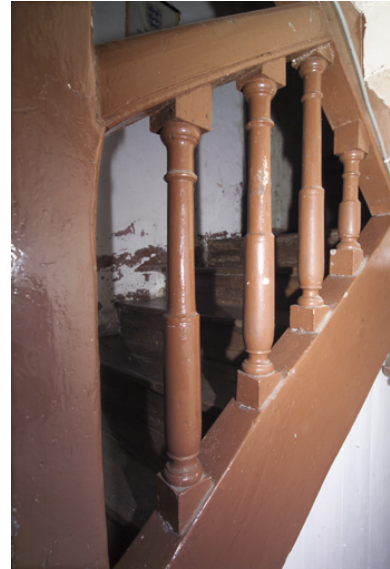
L'escalier, détail des balustres. Phot. Denis Pillet IVR52_20034400580NUCA
