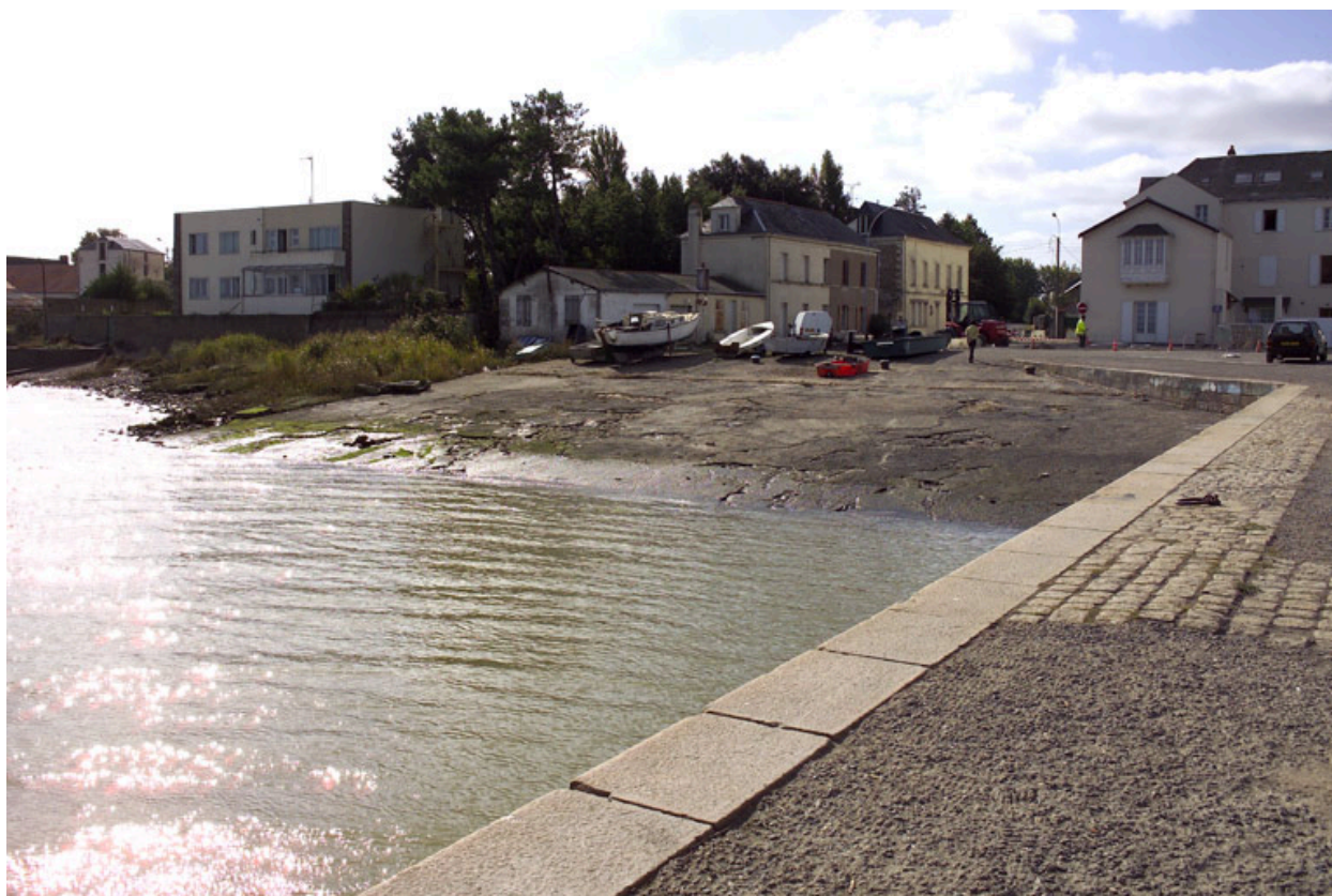
Vue d'ensemble de la façade est de la place Frégate-Arethuse depuis le quai Sadi-Carnot.
