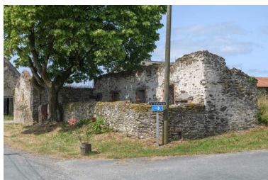
Toit à porcs de la Petite Touche Fleury. Phot. Armelle Maugin IVR52_20254900653NUCA
