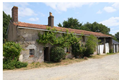
Vue d'ensemble de la façade sud du logis de la Petite Touche Fleury. Phot. Armelle Maugin IVR52_20254900663NUCA
