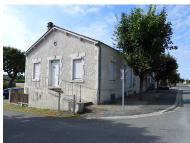
Le bâtiment vu depuis le nord. Phot. Yannis Suire IVR52_20188501278NUCA
