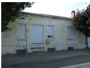
Les ouvertures de l'ancien café sur l'avenue, à l'ouest. Phot. Yannis Suire IVR52_20188501280NUCA
