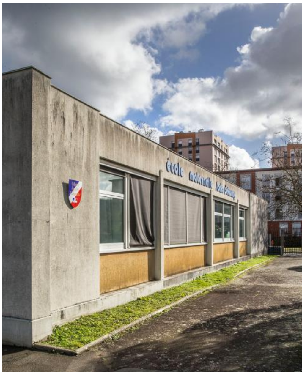
Vue de l'école maternelle Delaunay depuis le nord-ouest.
