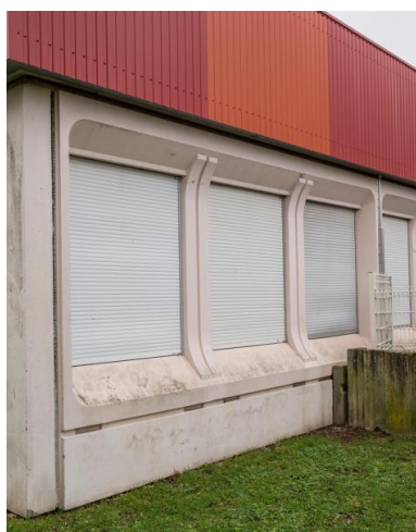
Vue d'un module sur la façade ouest de l'école rue de Roumanie. Phot. Pierre-Bernard Fourny IVR52_20197200008NUCA
