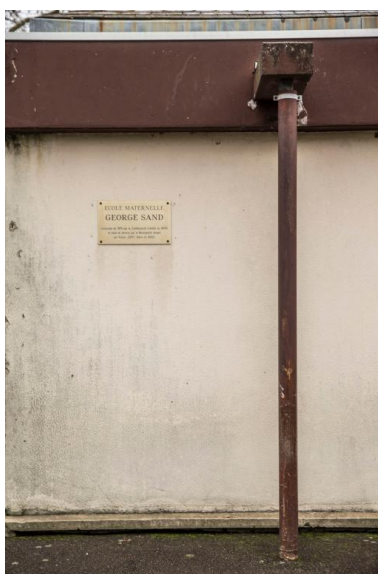
Détail de la gouttière et de la plaque du centre médico-pédiatrique. Phot. Pierre-Bernard Fourny IVR52_20197200006NUCA
