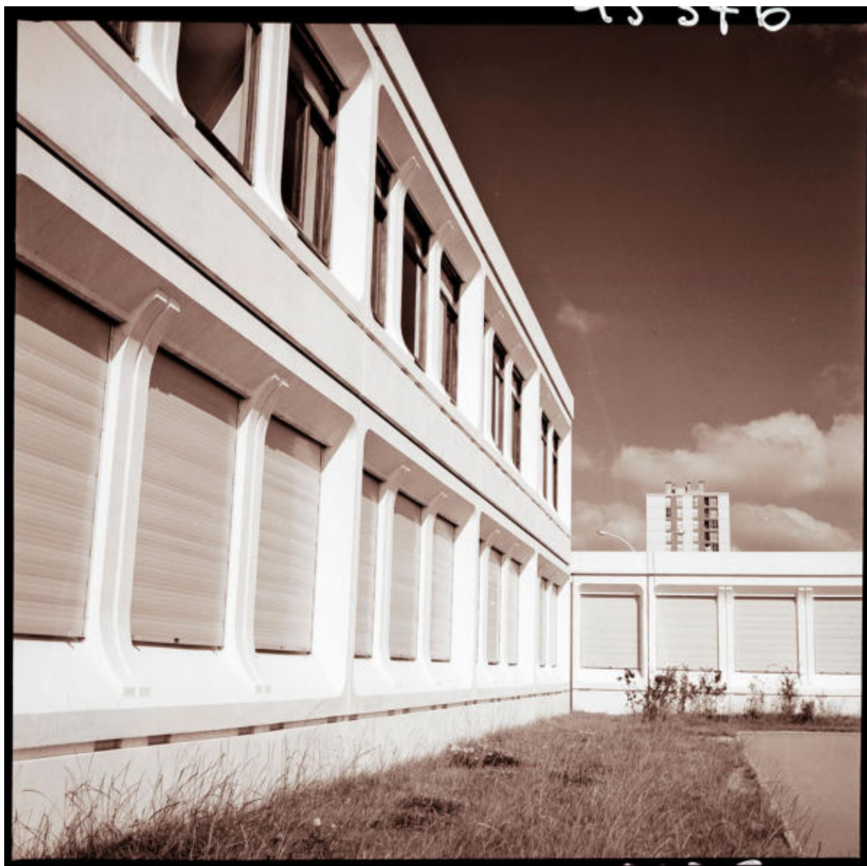
Vue des façades est et sud de l'école Arthur Rimbaud depuis la cour de récréation.
