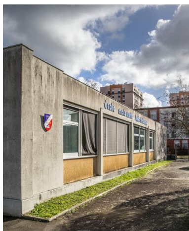
Vue de l'école maternelle Delaunay depuis le nord-ouest. Phot. Pierre-Bernard Fourny IVR52_20197200242NUCA
