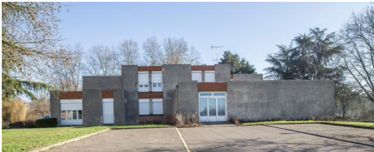
Vue des locaux des services techniques de la ville depuis le nord.
