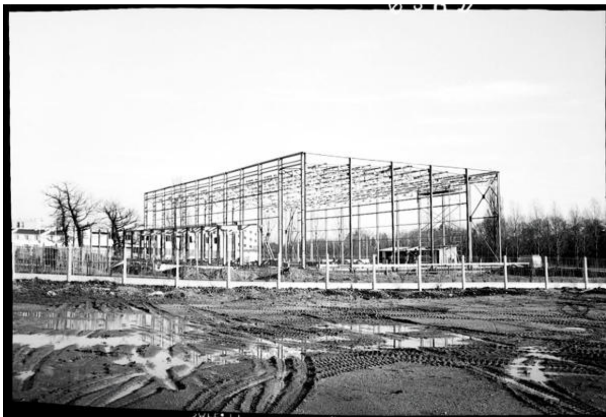
Vue de la construction du gymnase Alain-Fournier.
