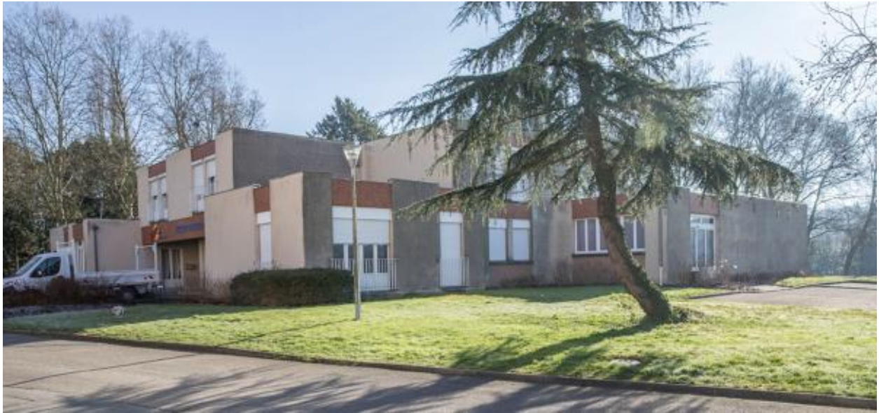
Vue des locaux des services techniques de la ville depuis l'est.
