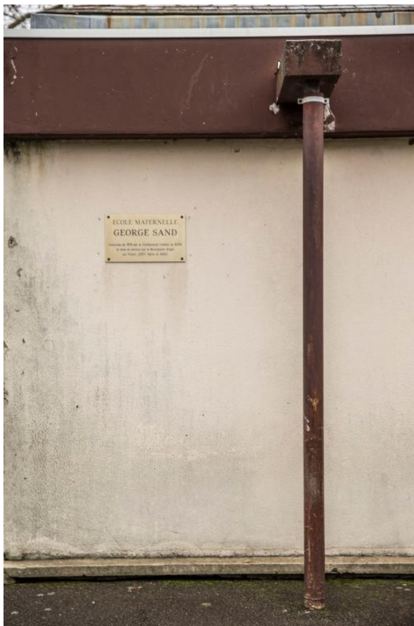
Détail de la gouttière et de la plaque du centre médico-pédiatrique.
