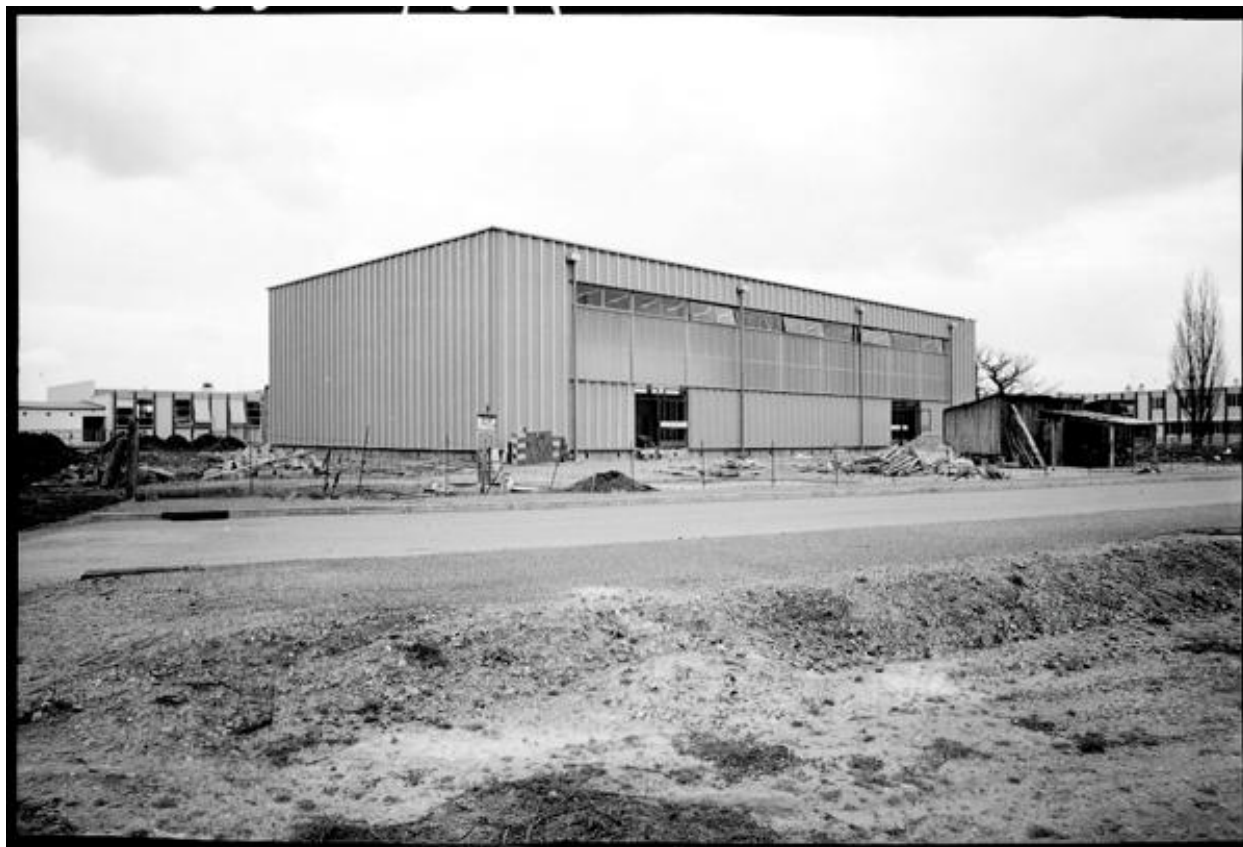
Vue du gymnase Alain Fournier depuis l'ouest.
