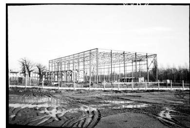
Vue de la construction du gymnase Alain-Fournier. IVR52_20197200415NUCA
