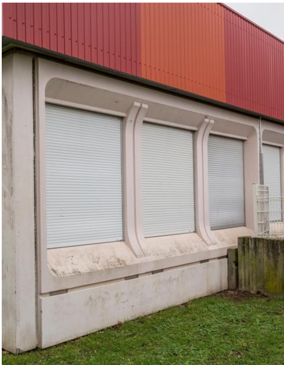
Vue d'un module sur la façade ouest de l'école rue de Roumanie.
