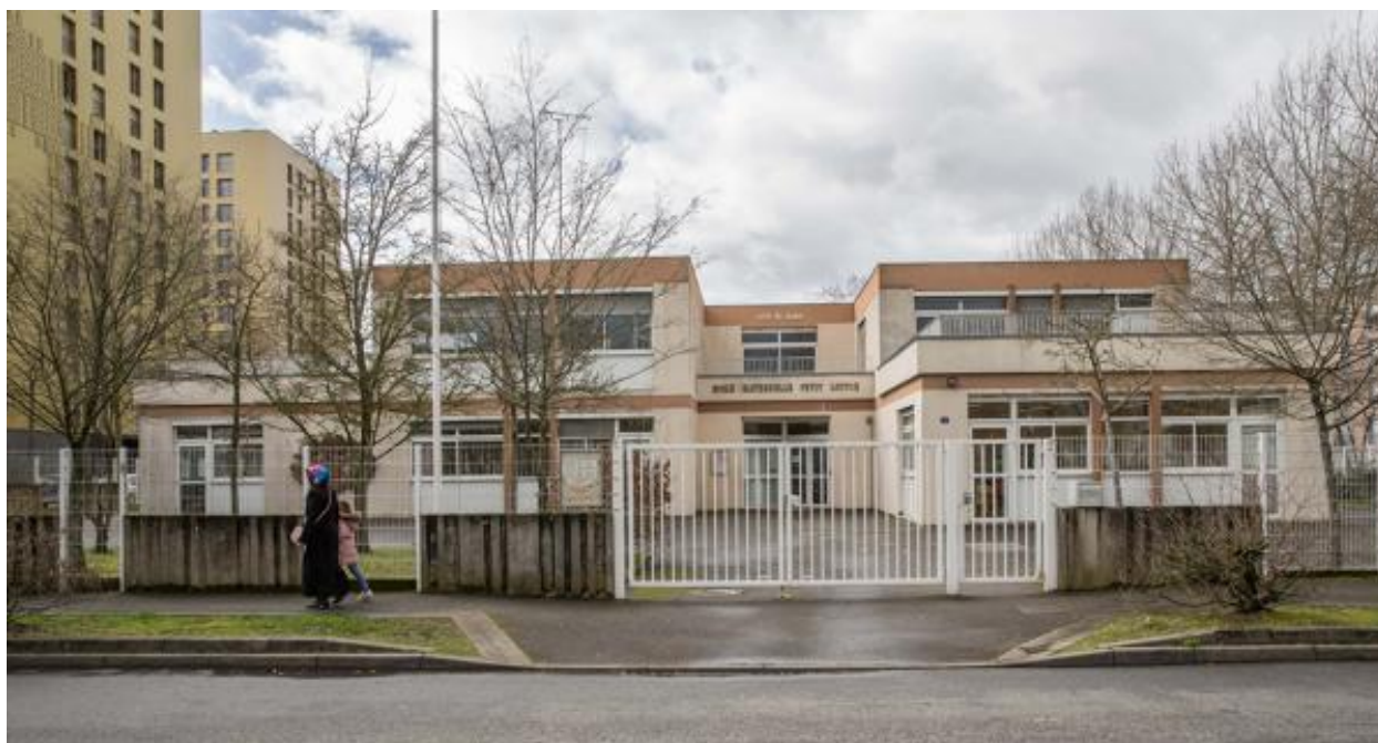
Vue de l'école du Petit Louvre depuis l'est.
