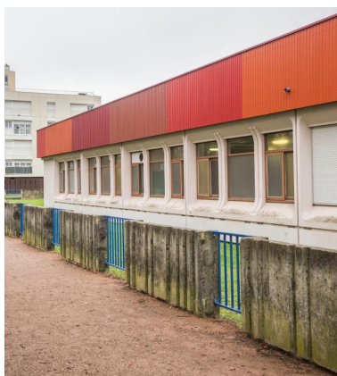
Façade nord de l'école des Sablonnières. IVR52_20197200009NUCA
