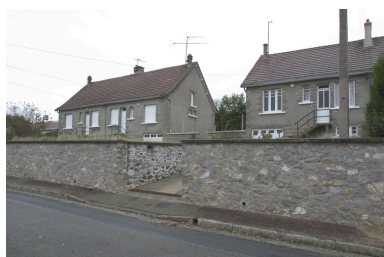
Vue d'ensemble depuis la rue.
