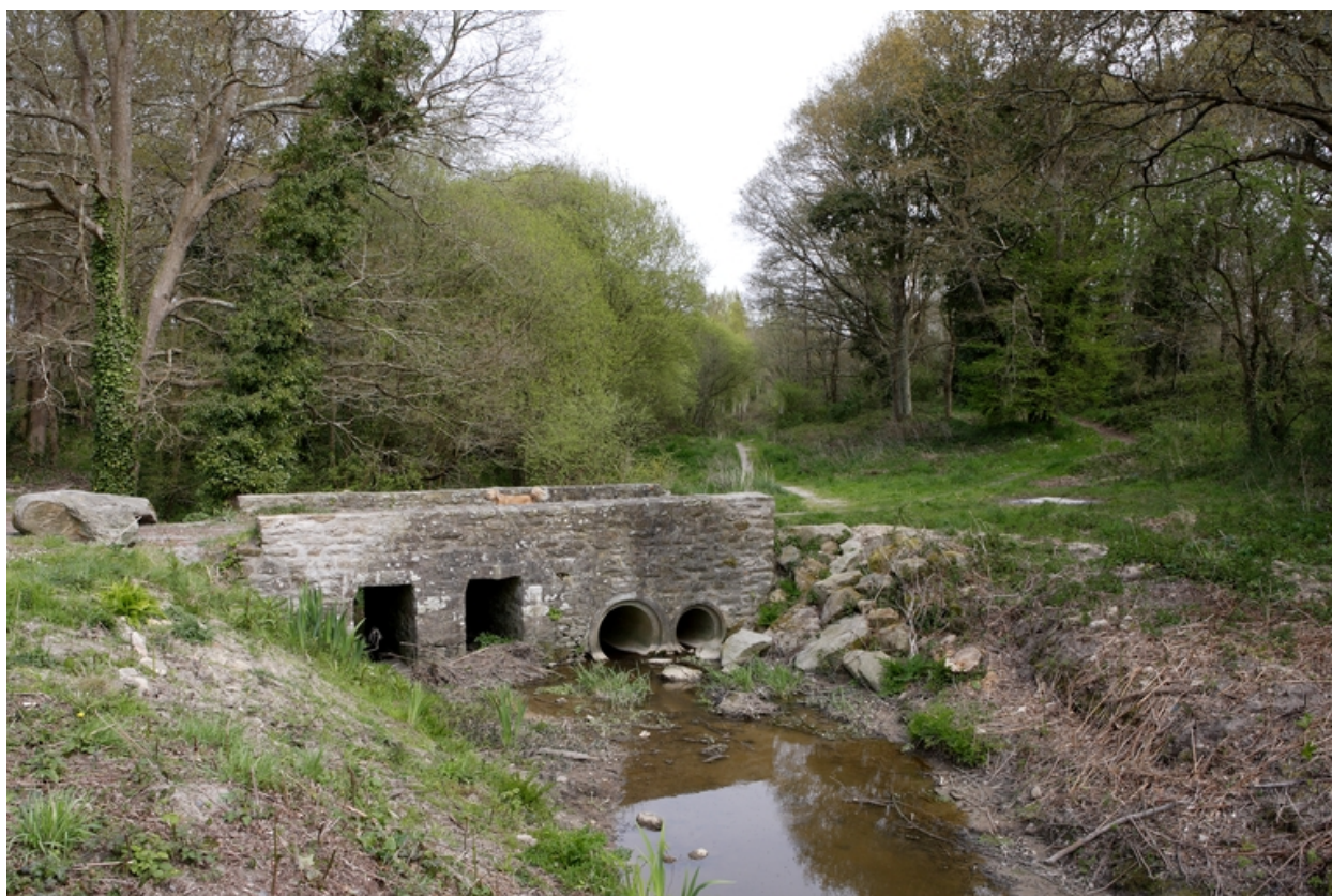
Le pont depuis le sud.
