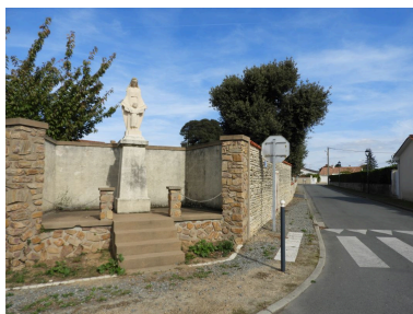
L'oratoire vu depuis l'ouest. Phot. Yannis Suire IVR52_20188500053NUCA
