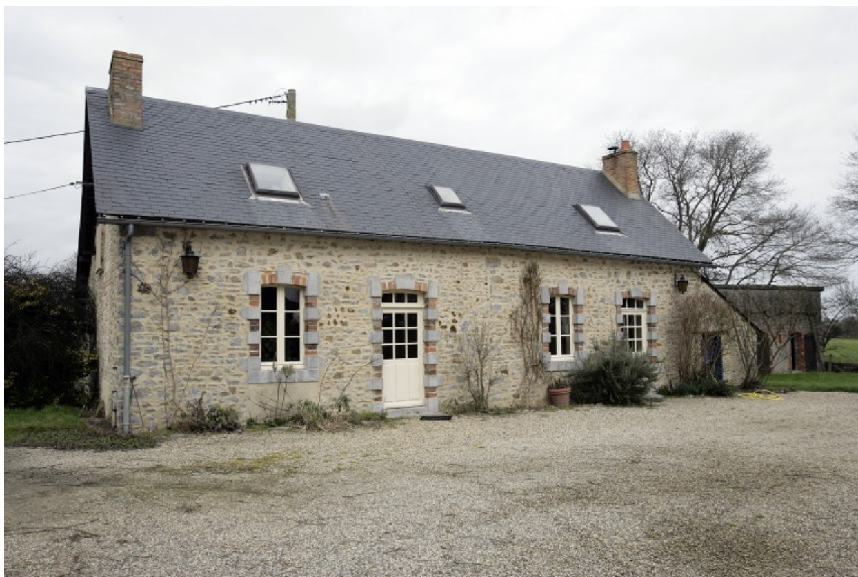
Le logis et, à droite, la porcherie, vus depuis la cour au sud.
