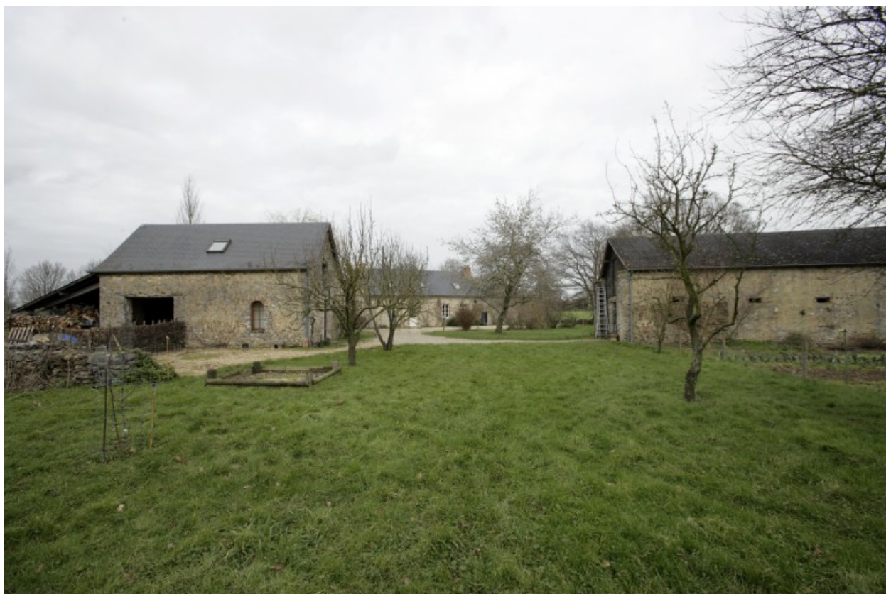
Vue d'ensemble depuis le sud-ouest : au premier plan, les deux étables ; au second plan, le logis.
