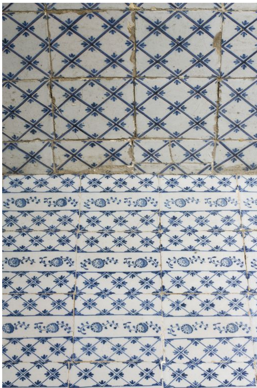
Château de Courcival, cabinet de bains : détail du carrelage de sol et de la partie basse du carrelage mural.
