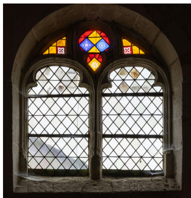
Fenêtre de la chapelle latérale, côté sud : verrière. Phot. Jeanne Minier IVR52_20257200365NUCA
