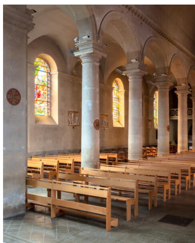
Vue du bas-côté sud depuis la nef. Phot. Paul Hamelin IVR52_20227200180NUCA
