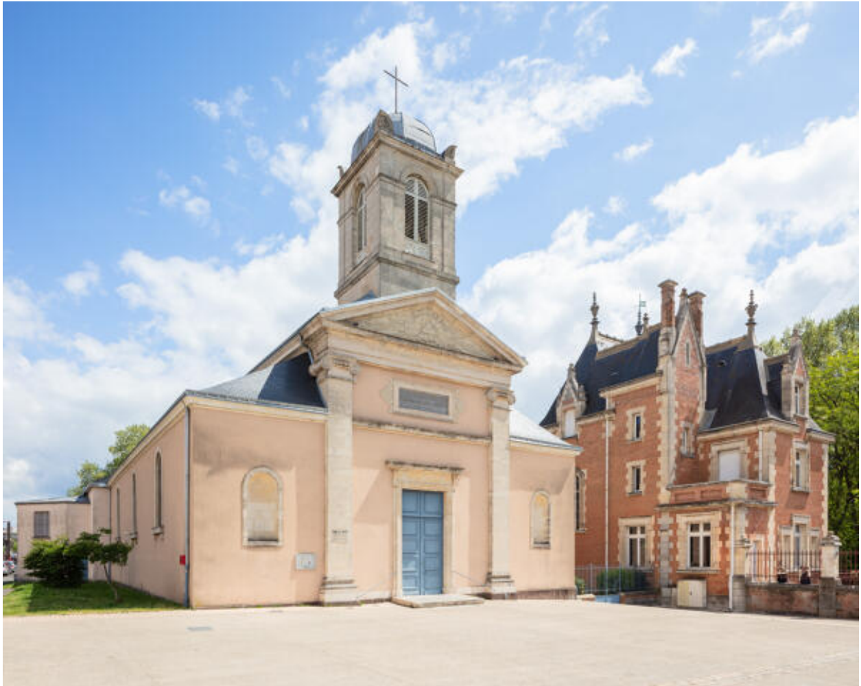
Vue de l'église depuis le nord-ouest.
