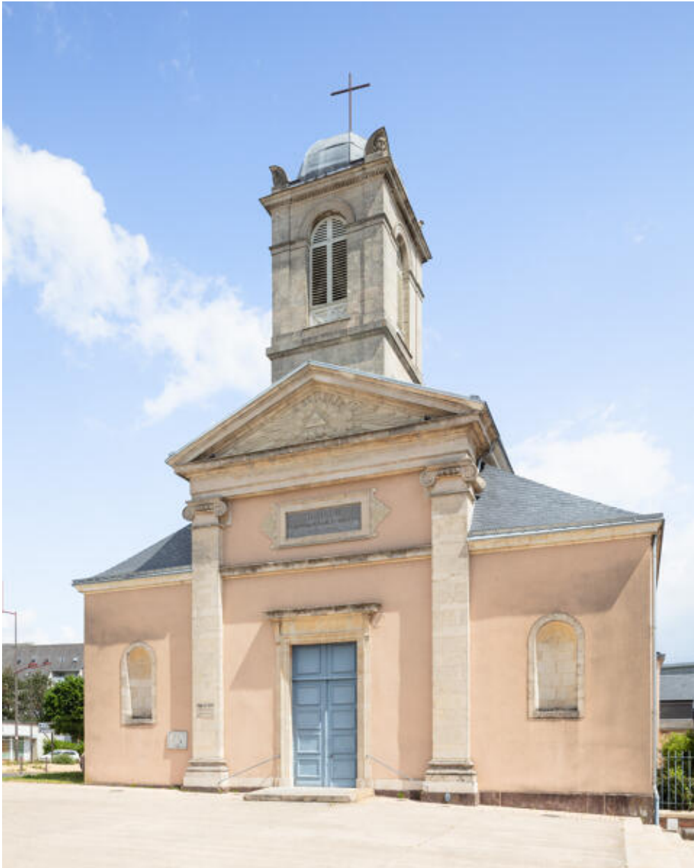
Vue de la façade principale de l'église.
