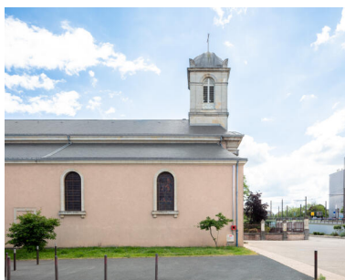
Vue du bas-côté nord de l'église. Phot. Paul Hamelin IVR52_20227200189NUCA
