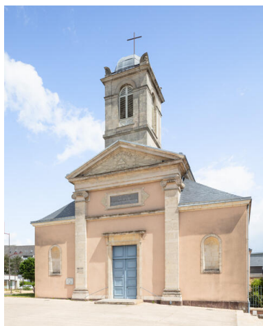
Vue de la façade principale de l'église. Phot. Paul Hamelin IVR52_20227200187NUCA
