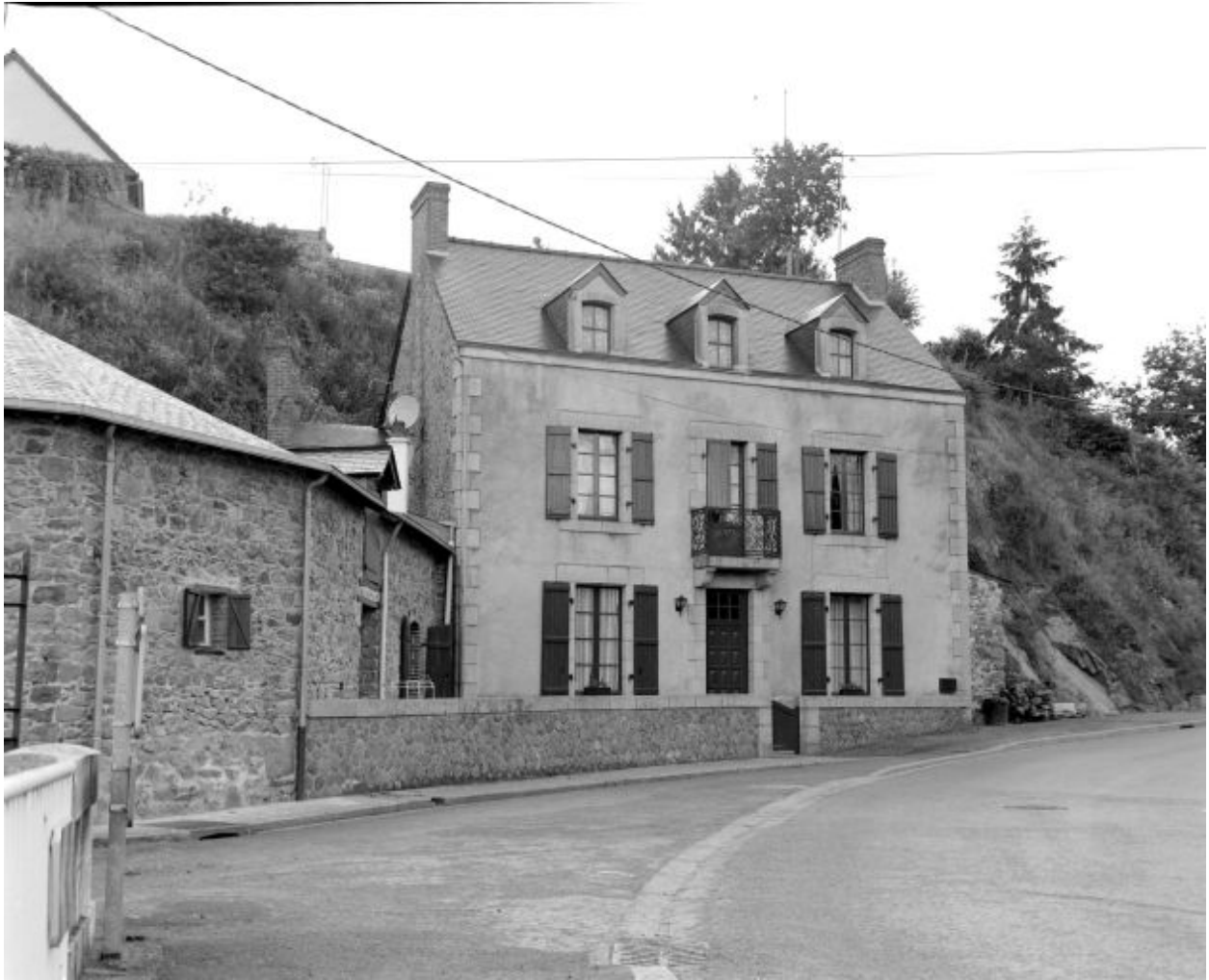
La façade principale.
