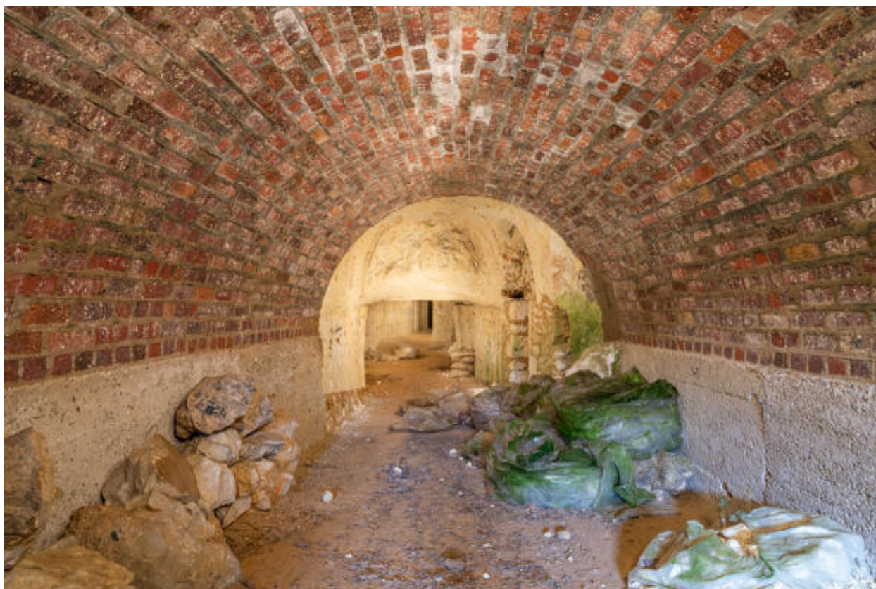
Vue au niveau de l'entrée.
