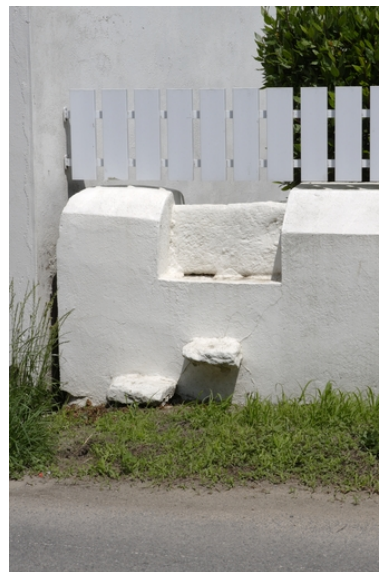
Détail de l'échelier. Phot. Denis Pillet IVR52_20104401161NUCA
