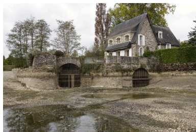
Façade nord-est, en amont, des vestiges du bâtiment du moulin, pendant les écourues de 2009 : soubassement du moulin avec les entrées des deux coursiers, logis du meunier (remanié).
