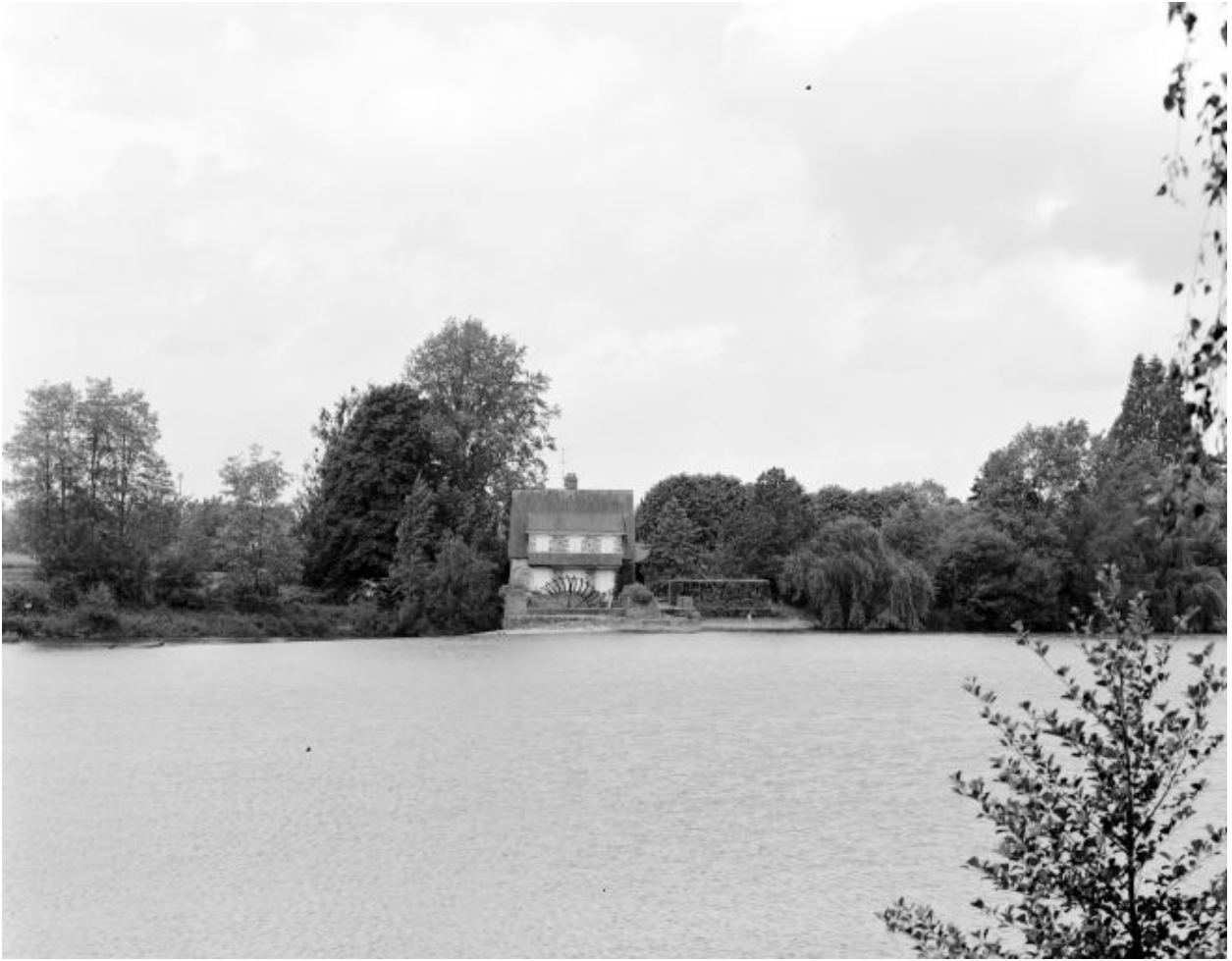
Le soubassement du moulin et la roue du large vus du sud-est, depuis le moulin du Gué.
