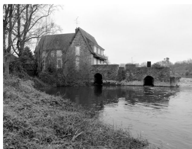
Façade sud-ouest, en aval, des vestiges du bâtiment du moulin : culée du barrage, soubassement du moulin avec les sorties des deux coursiers, logis du meunier (remanié). Phot. François Lasa IVR52_20015300754X
