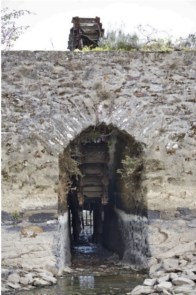
La sortie du coursier du large, pendant les écourues de 2009.
