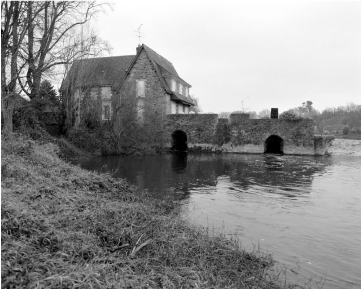
Façade sud-ouest, en aval, des vestiges du bâtiment du moulin : culée du barrage, soubassement du moulin avec les sorties des deux coursiers, logis du meunier (remanié).
