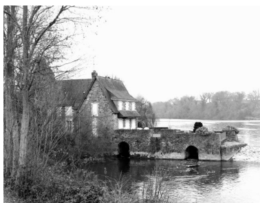
Façade sud-ouest, en aval, des vestiges du bâtiment du moulin : culée du barrage, soubassement du moulin avec les sorties des deux coursiers, logis du meunier (remanié). Phot. François Lasa IVR52_20015300753X
