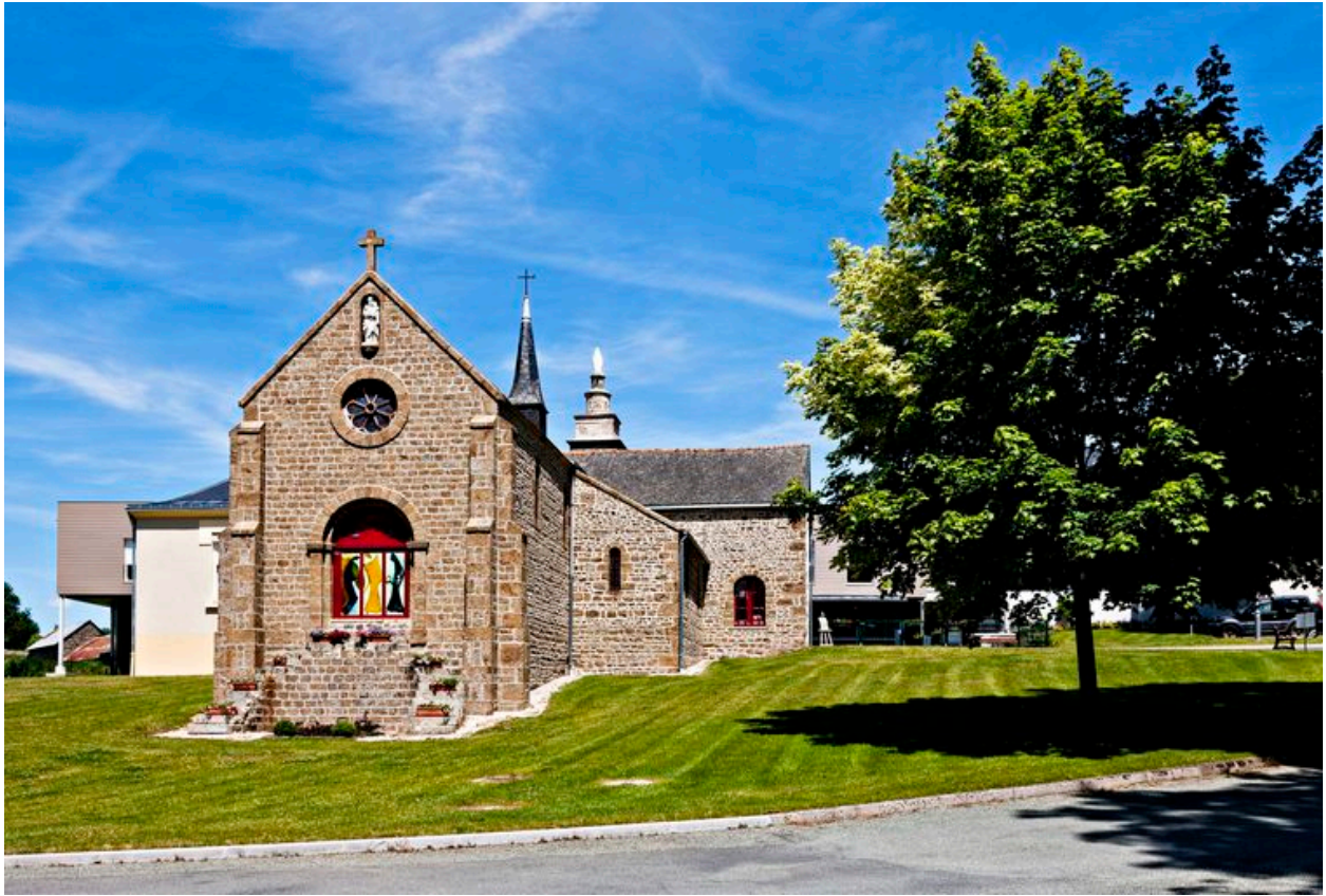
La chapelle vue depuis le sud.
