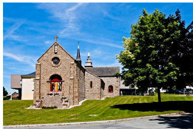
La chapelle vue depuis le sud. Phot. Yves Guillotin IVR52_20155300068NUCA
