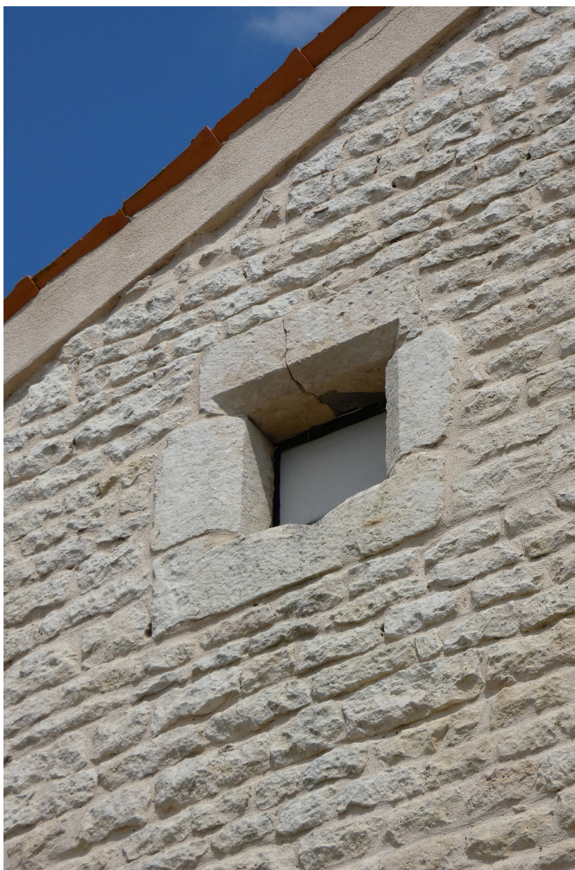
Petite baie à encadrement chanfreiné sur le mur pignon ouest du logis.
